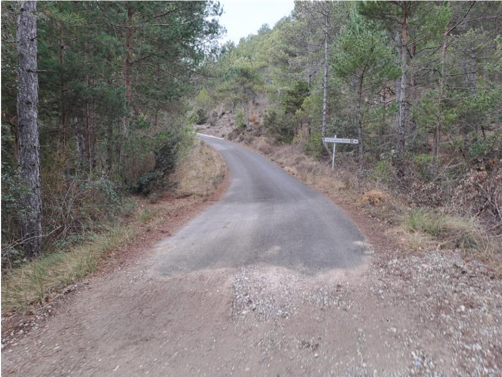
Vista del tram final on connecta amb el terme municipal de la Coma i la Pedra que ja es troba pavimentat
