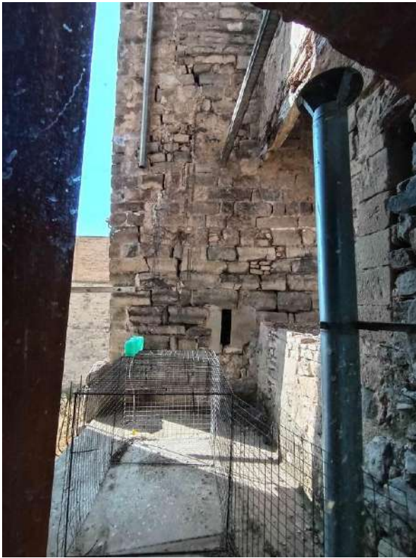
2. Imatges de l'exterior de la sala de l'Olier.
