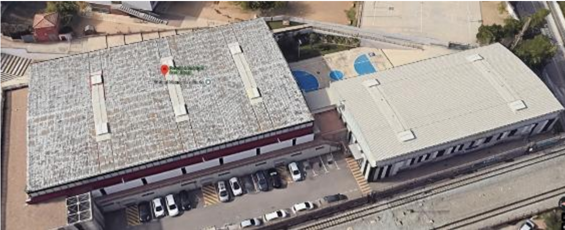
Cobertes del Poliesportiu Municipal Sant Josep: Coberta de la pista poliesportiva a 2 aigües i coberta pista annexa de forma corba.
