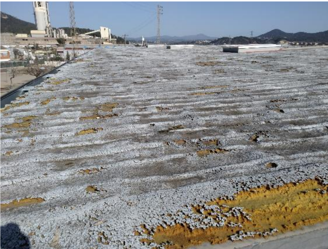
Coberta de la pista poliesportiva: aïllament projectat existent.
