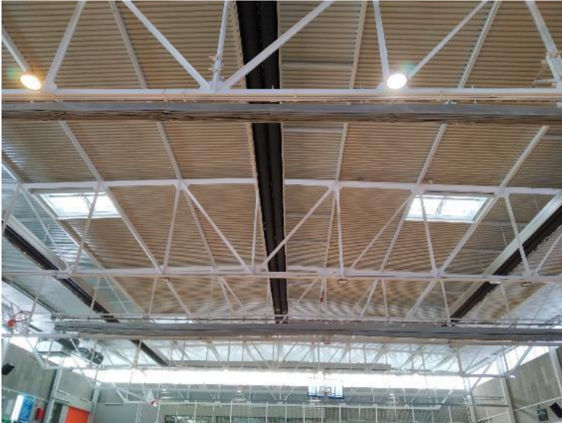
Vista del sostre de la pista poliesportiva.
