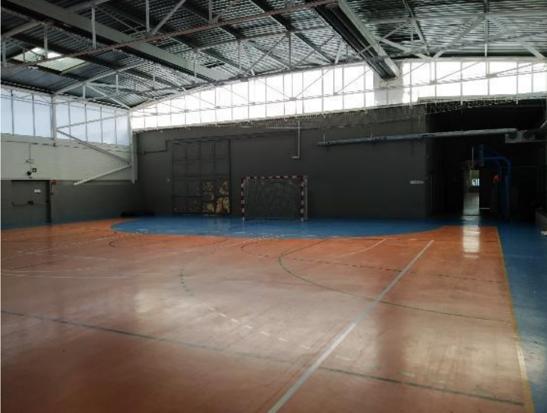
Coberta de la pista annexa: vista interior de l'estructura d'encavallades.
