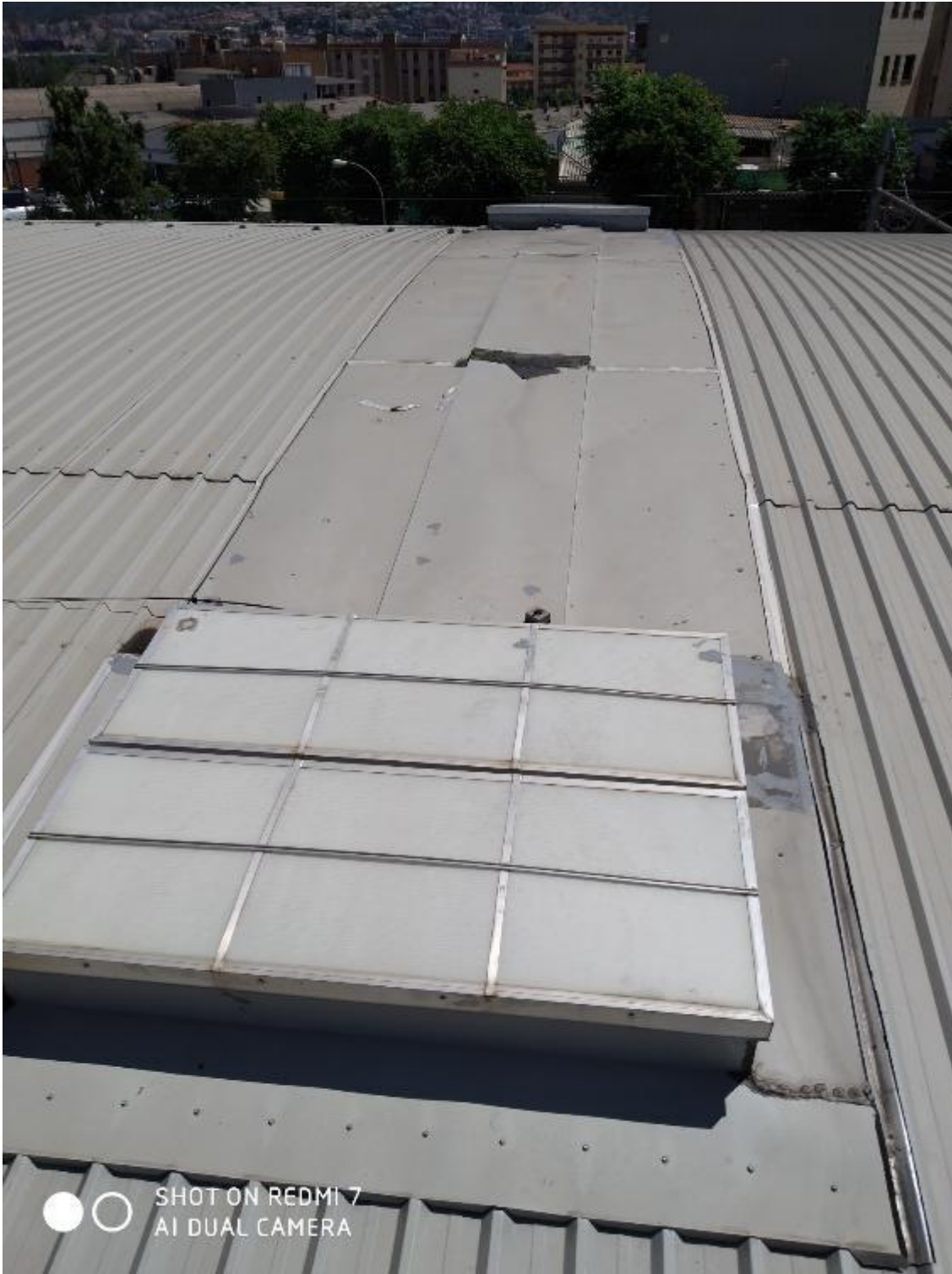
Coberta de la pista annexa: vista exutori amb xapa intermèdia entre les dues obertures.
