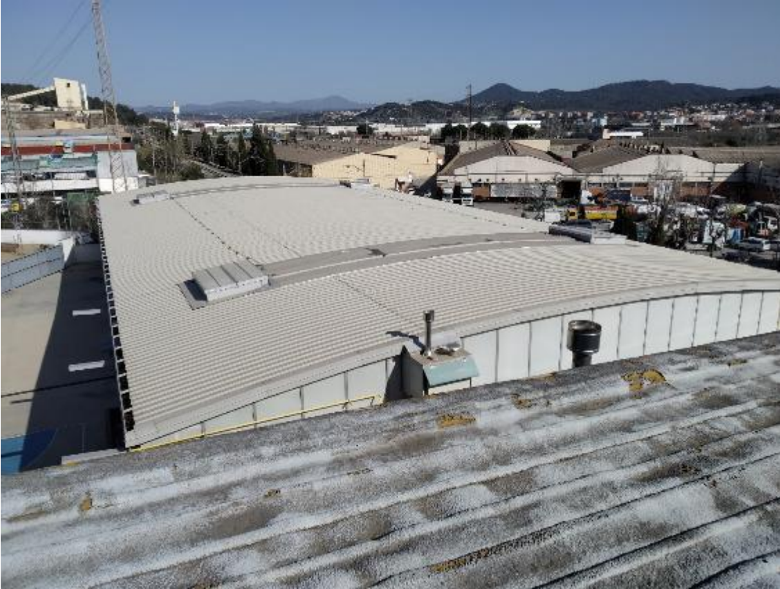
Coberta de la pista annexa: coberta de xapa de forma corba amb 4 exutoris.
