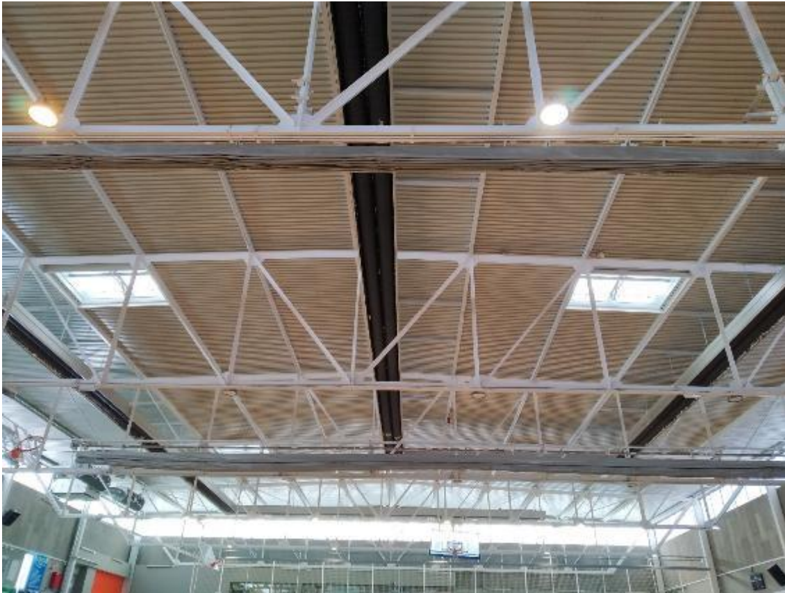
Coberta de la pista poliesportiva: vista interior de l'estructura d'encavallades.
