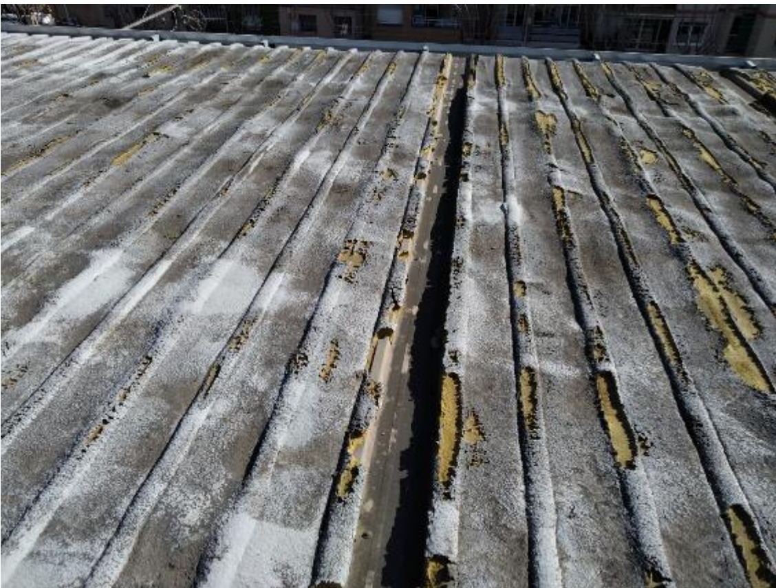
Coberta de la pista poliesportiva: canals d'aigua verticals.
