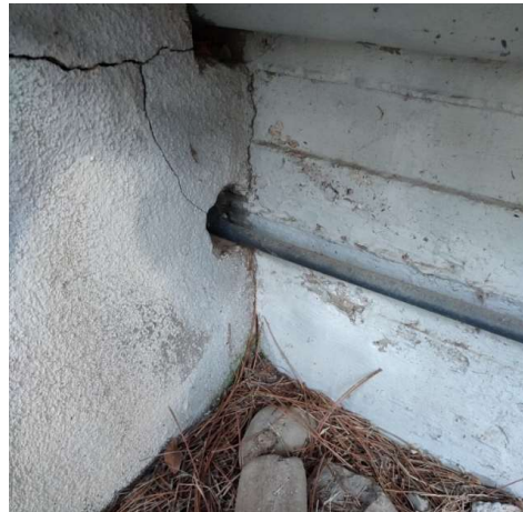
Figura 7 Pas de instal·lacions a l'escala de l'Obra d'Arribada
