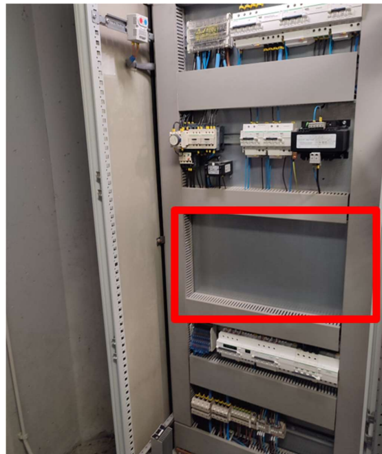
Figura 11, Espai disponible per als dispositius de potència, armari COOA
