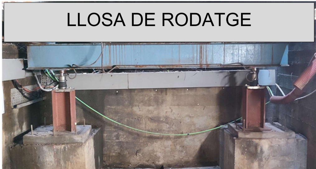
Figura 5 Objectiu, llosa de rodatge recolzada als travessers actuals (no es representen els suports addicionals)
