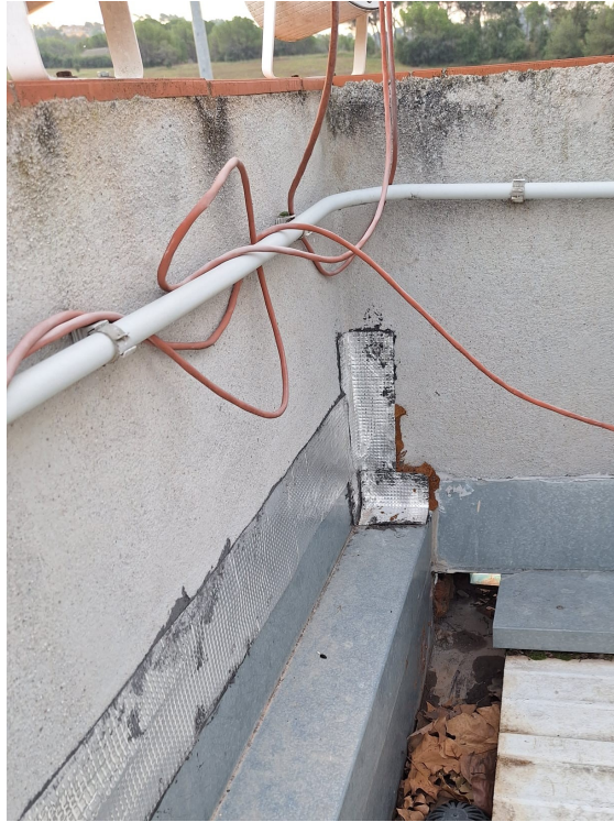
Vista detall canal oculta coberta
