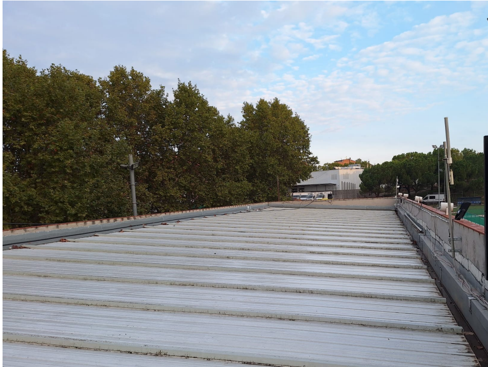
Vista de la coberta de l'edifici A a substituir funcionalment
