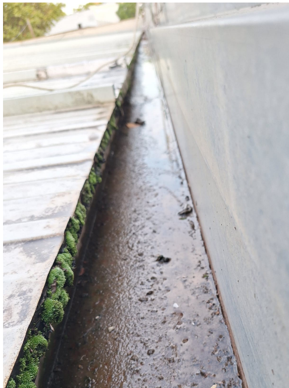
Vista detall canal oculta coberta
