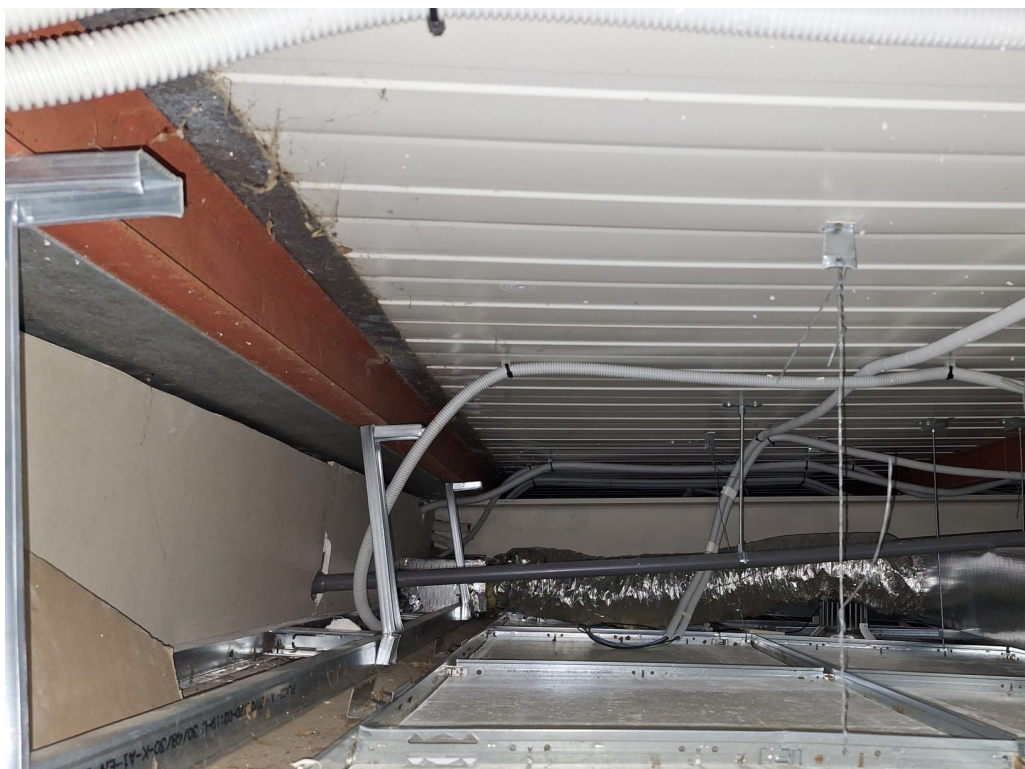
Vista de l'estructura de suport de la coberta
