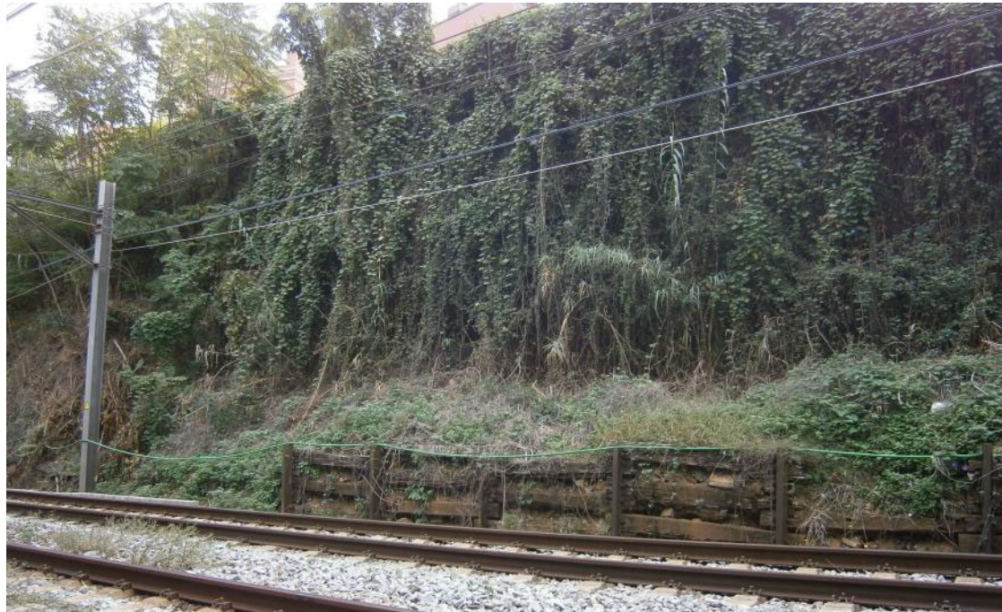
Part central, amb sosteniment al peu a base de travesses.
