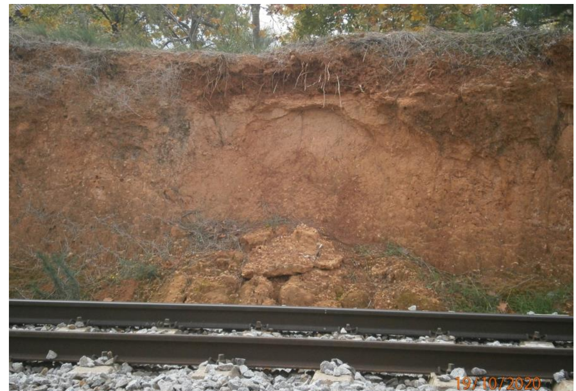
Detall d'esllavissada en el p.k. 7+053
