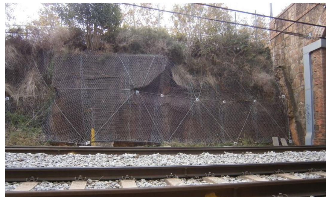
Vista de la zona sostinguda amb geomalla
