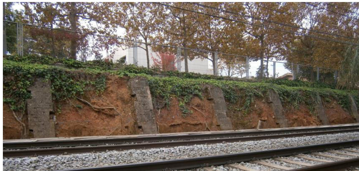
Vista de la zona amb contraforts de formigó
