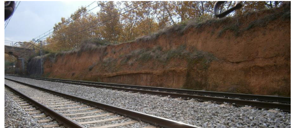
Vista del talús en un tram sense reforços
