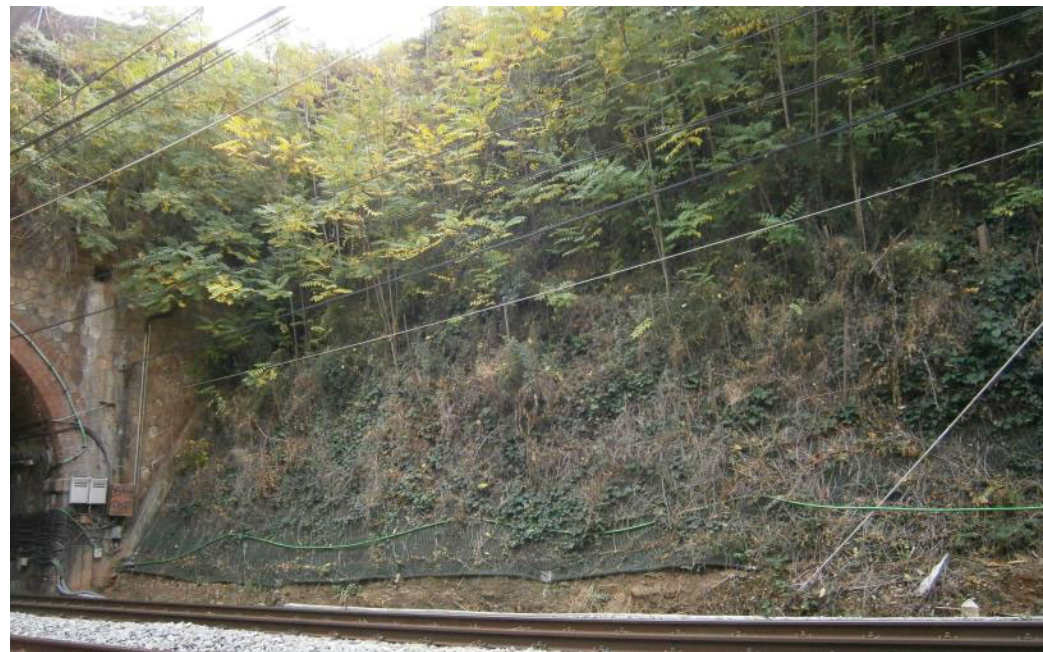
Zona propera al túnel de Sarrià
