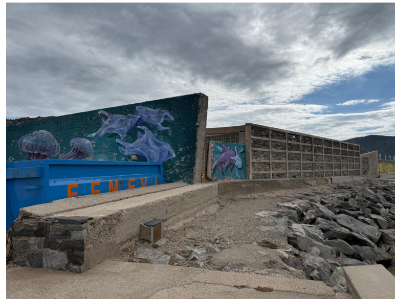
DOCUMENTACIÓ FOTOGRÀFICA ESTAT ACTUAL - VOLUMS A ENDERROCAR - FAÇANA NORD A REHABILITAR
