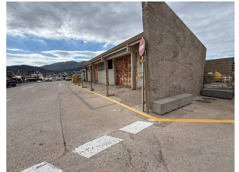
DOCUMENTACIÓ FOTOGRÀFICA ESTAT ACTUAL - VOLUMS A ENDERROCAR I VOLUMS FAÇANA EST A REHABILITAR
