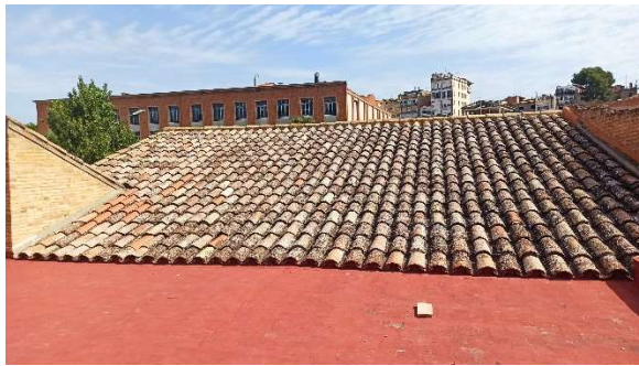
IMATGE 01. Coberta inclinada
