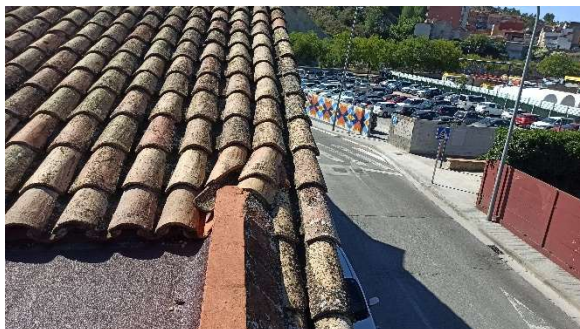
IMATGE 03. Coberta inclinada
