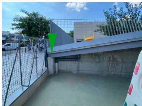
Anclatge a biga existent Cal elaborar planxa registrable per tapar baixant
