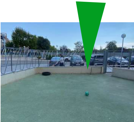
Mur perimetral anclatge mur Pòrtic 9
