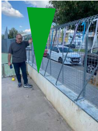
Mur perimetral suport encastat P6'
