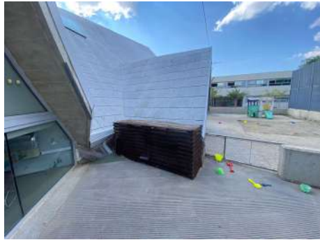
retirada de porteta metàl·lica i col·locació sobre muret de connexió Portic 2
