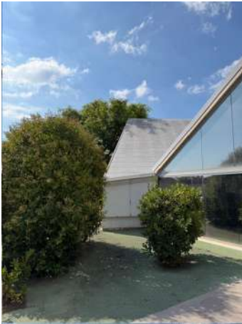
Mur encreuament portic 7 i 8
