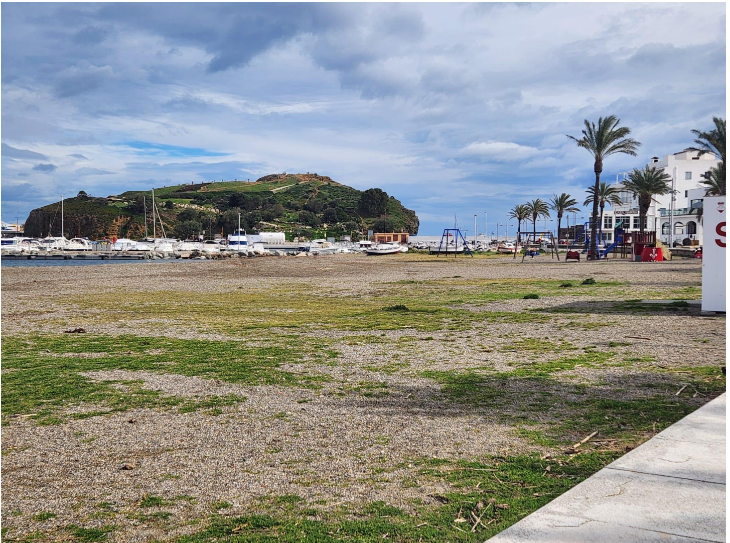
Zona de la platja del port, a on s'ha de treure material per portar-lo al mig de la badia.
