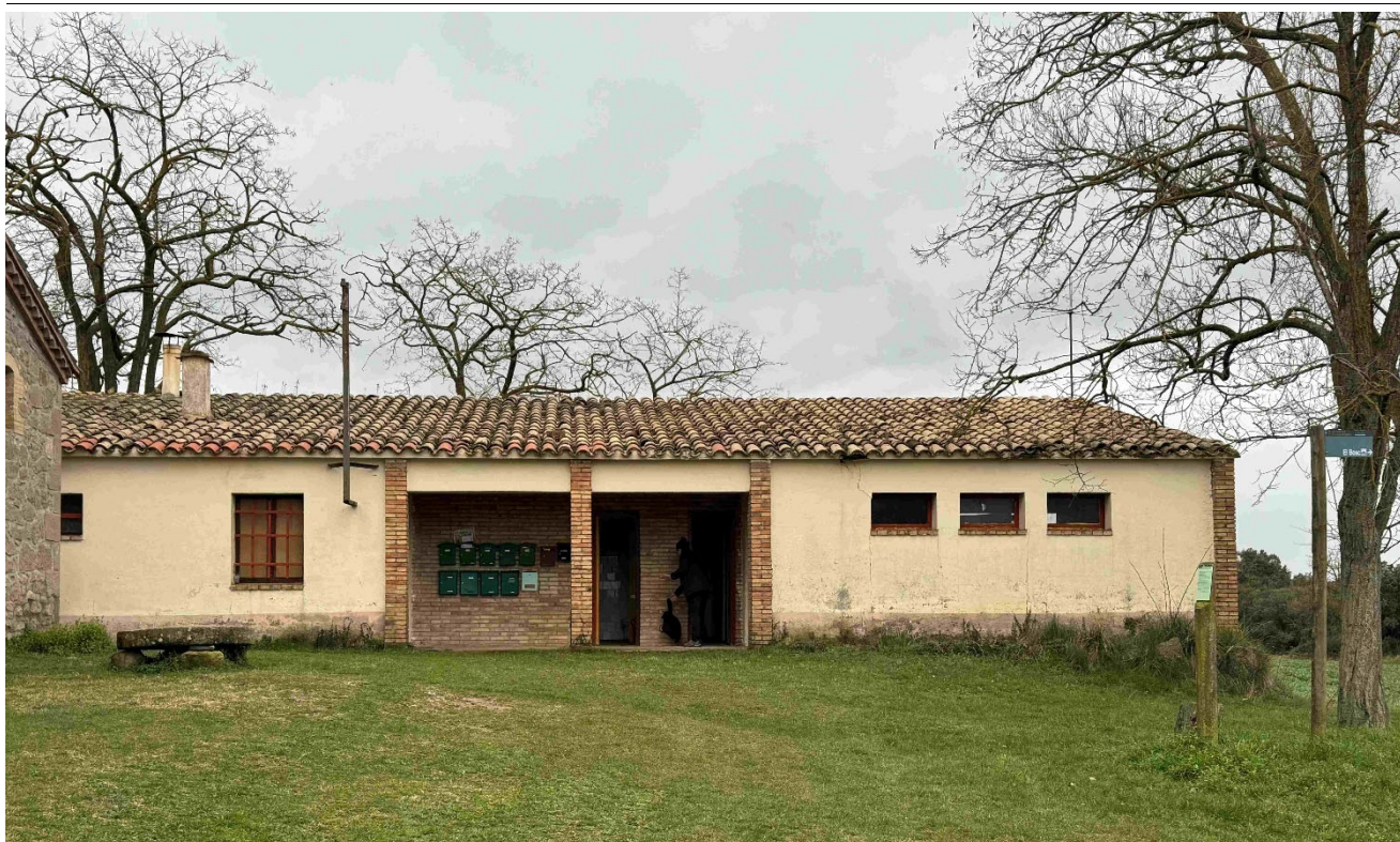
Façana principal, on hi ha l'accés. Està orientada a ponent.
