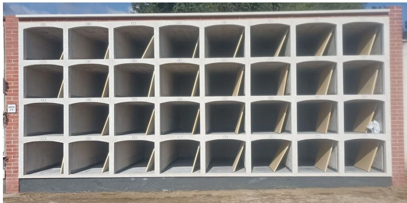
Foto nº 5. Vista frontal d'una illa de 40 nínxols en el cementiri del Vendrell construïda a l'any 2024.
