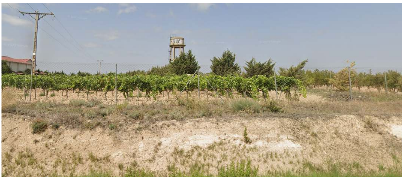
Dipòsit elevat. 60 m3
