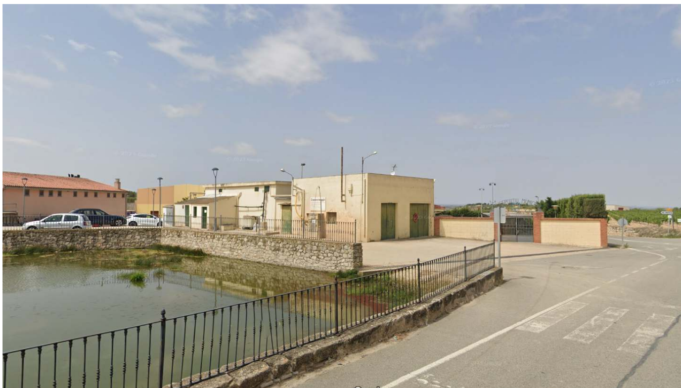
Dipòsit soterrat (piscina). 200 m3
