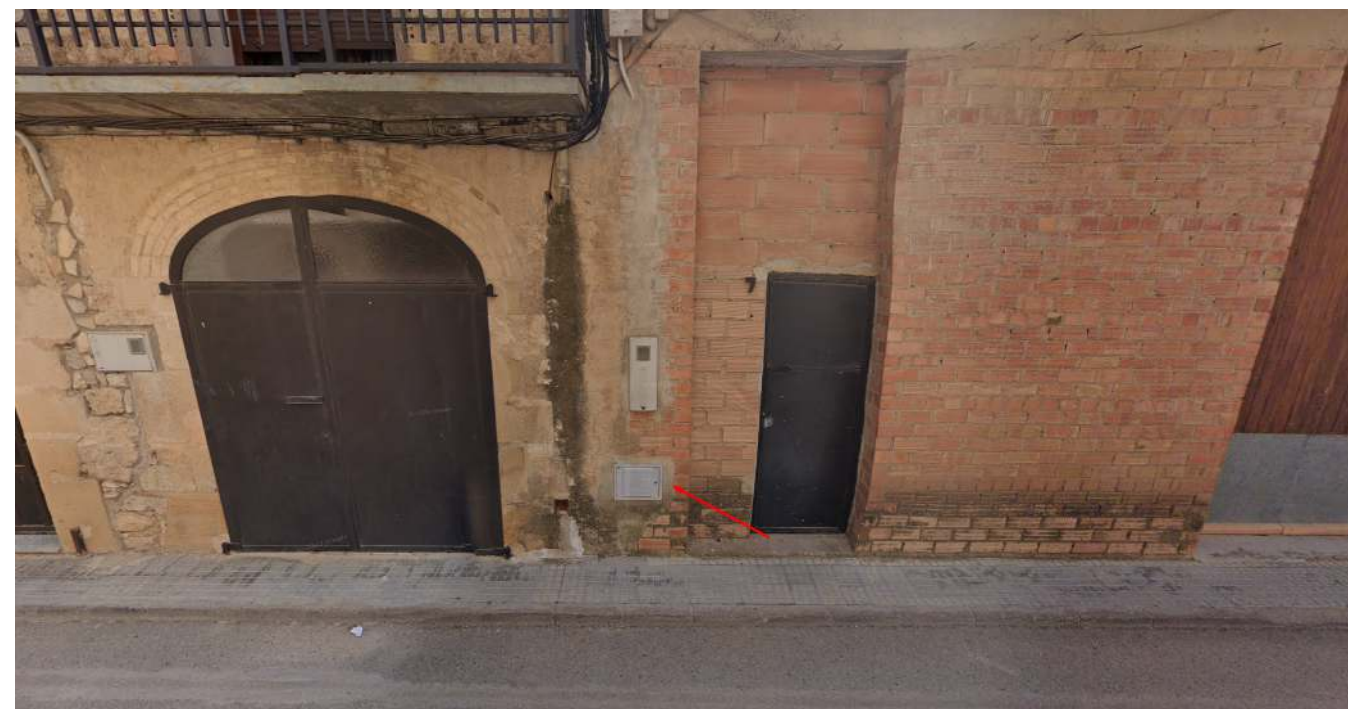
Exemple d'ubicació de comptador d'aigua en armari de façana (c/ Gandesa)
