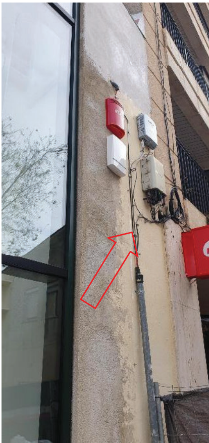
Reordenar Cables façana mur cortina
