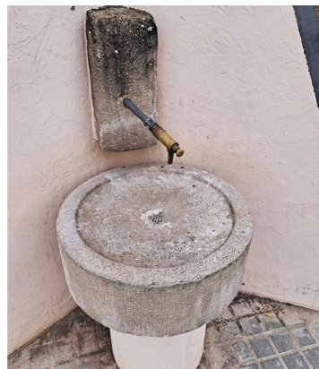
Pila recuperada Neteja amb xorrejat d'aigua i substitució de desguàs
