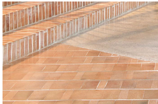
Paviments Peça ceràmica manual col.locada de pla amb i formigó in situ rebaixat i polit.
