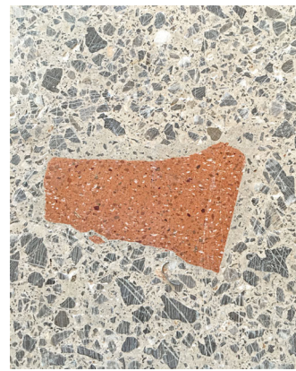
Insercions formigó en massa amb insercions ceràmiques provinents de les merms del paviment
