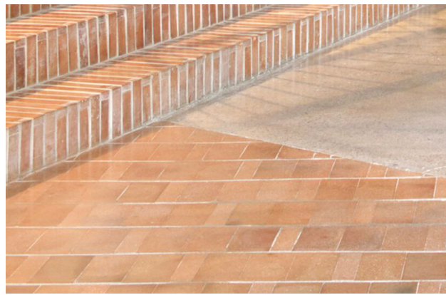
Paviments Peça ceràmica manual col.locada de pla amb i formigó in situ rebaixat i polit.
