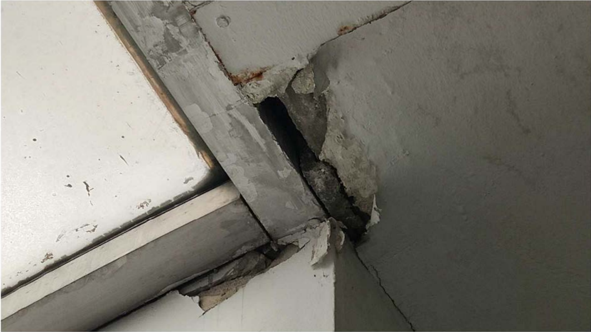
01. REPARACIÓ DE LA TROBADA DE L'ESTRUCTURA DE LA CLARABOIA AMB EL FORJAT SUPERIOR (PL. COBERTA)
