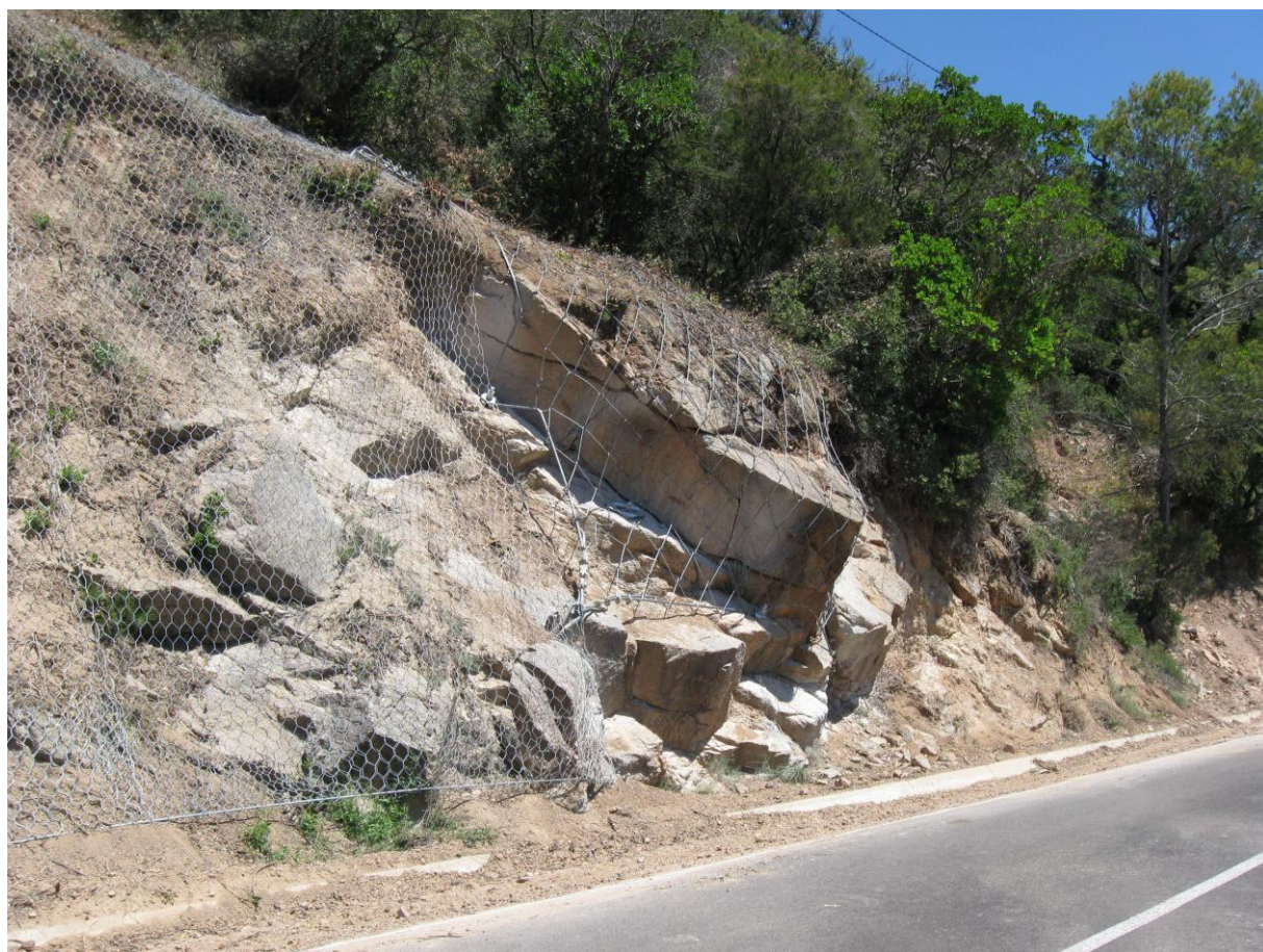
Figura 6. Exemple d'estabilització
