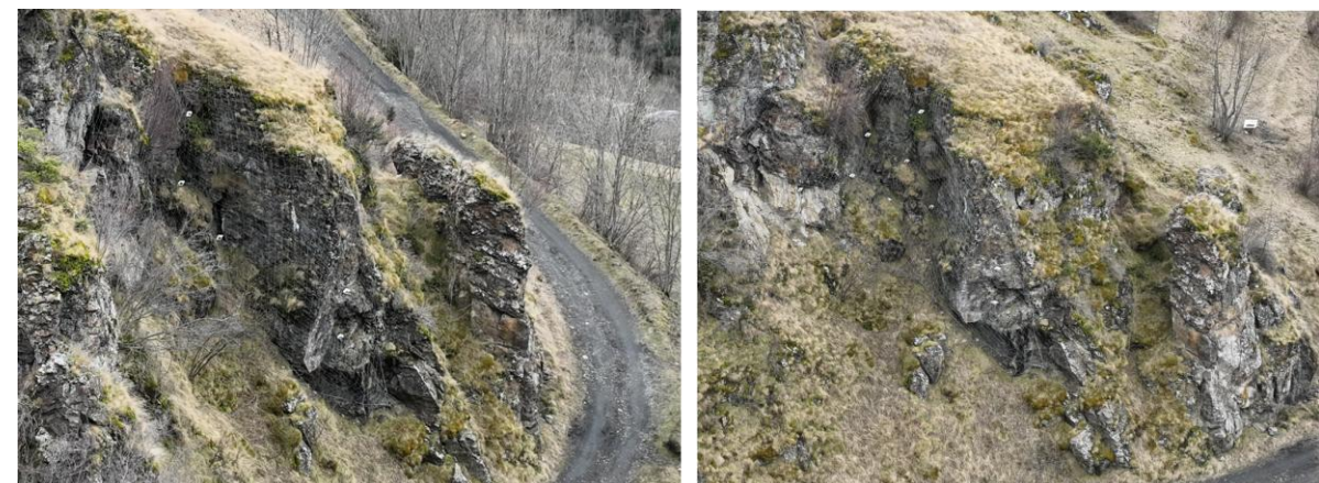
Figura 2. Imatges aèria durant l'inspecció.
