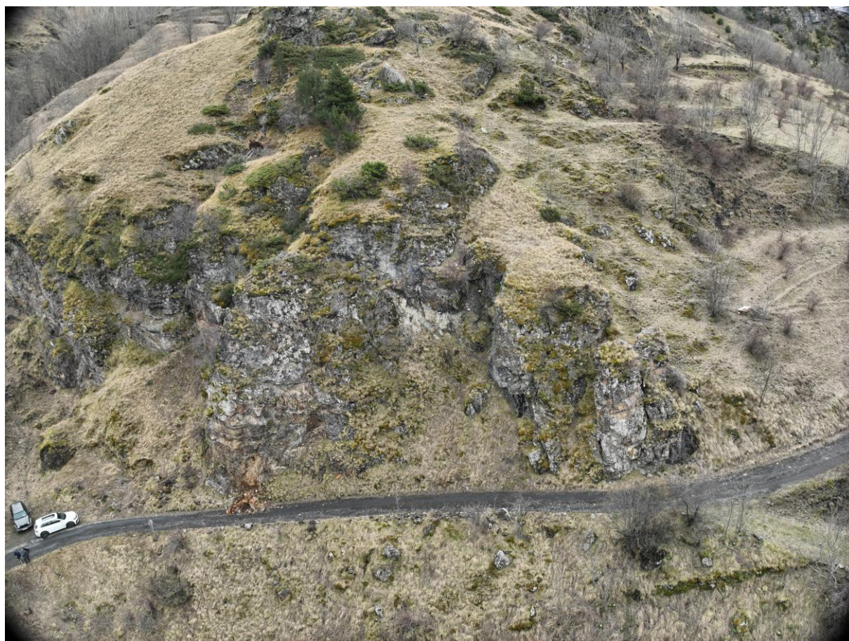
Figura 1. Imatges durant l'inspecció.
