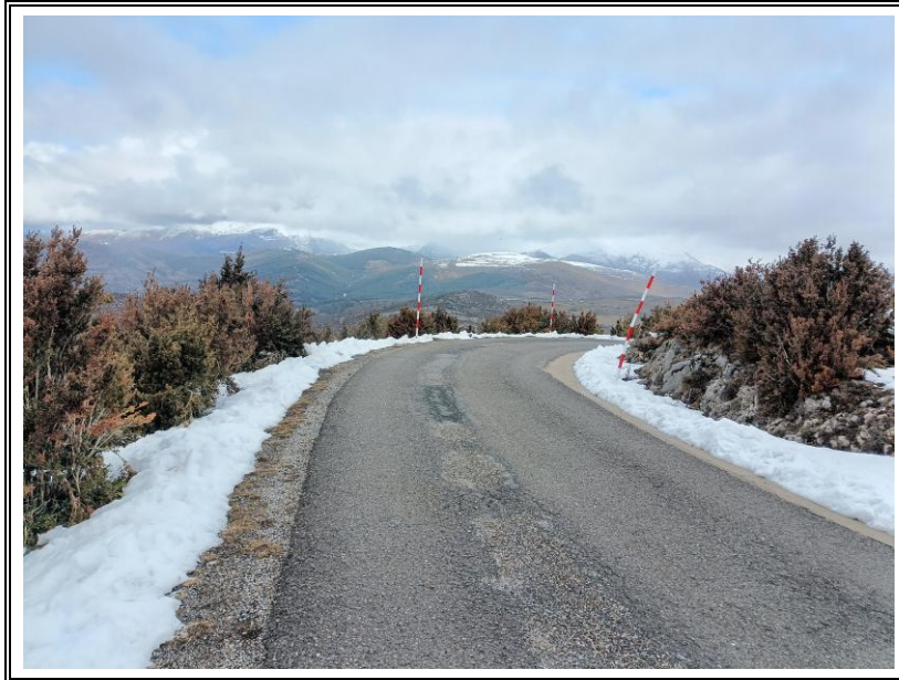
Figura 7. Vista actual de l'accés de Corroncui on cal instal·lar tanca de seguretat. Gener del 2026.
