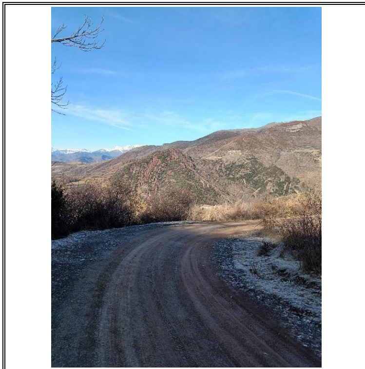
Figura 8. Vista actual de l'accés d'Erta on cal instal·lar tanca de seguretat. Gener del 2026.
