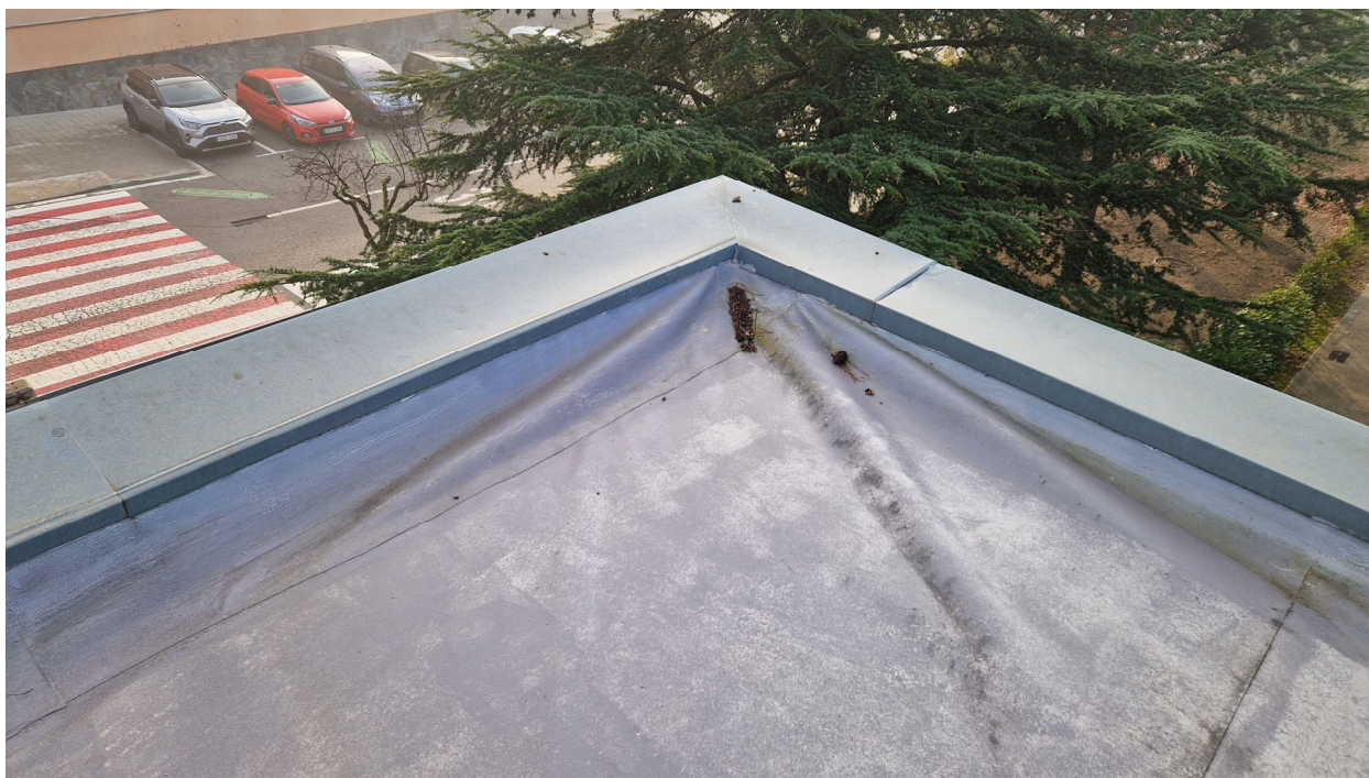
Cantonada sud-est, zona alta coberta
