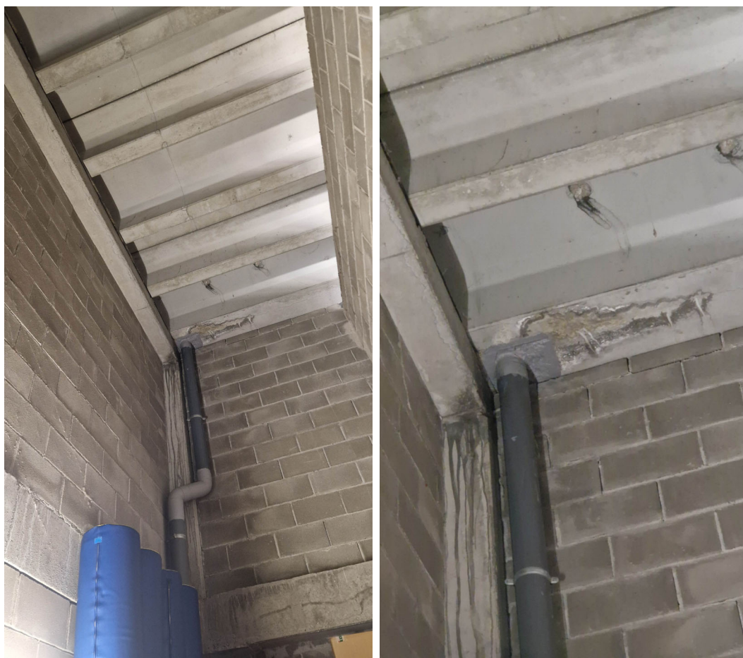
Baixant sud-oest des de l'interior
