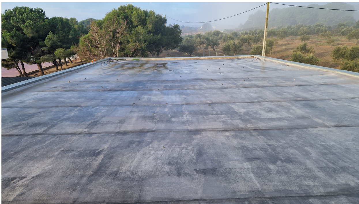
Vista de coberta cap a l'oest, al fons el canaló
