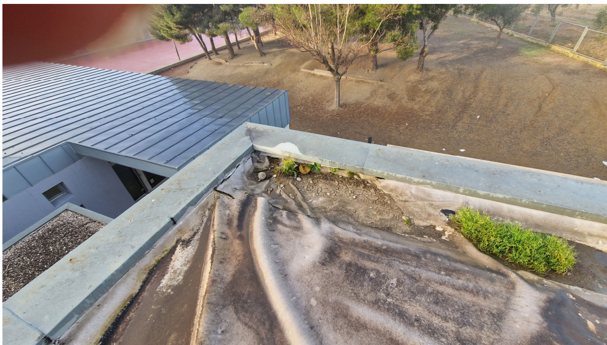
Baixant cantonada sud-oest
