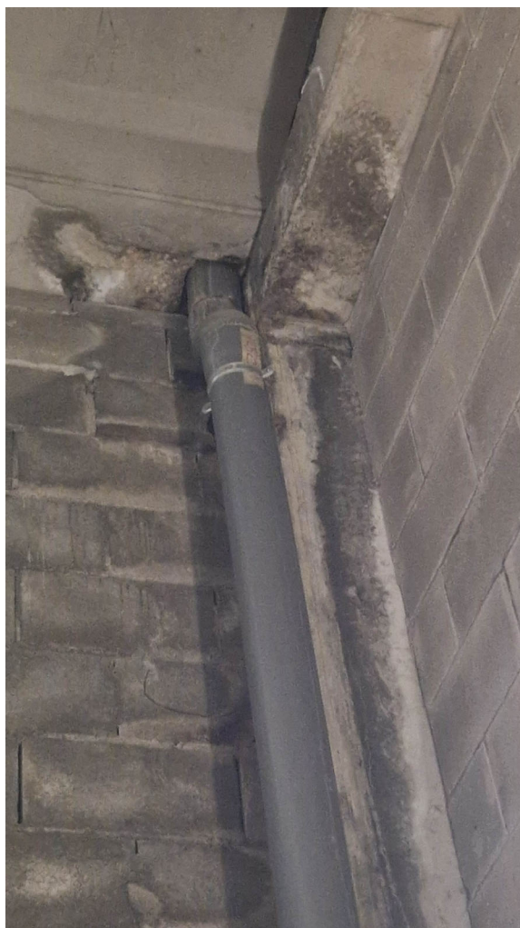
Baixant nord-oest des de l'interior
