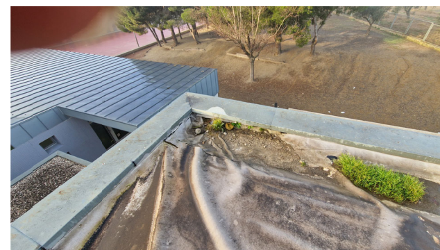
Baixant cantonada sud-oest
