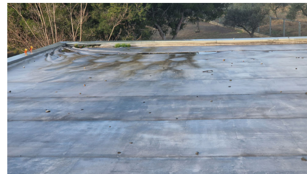
Canaló a vora oest
