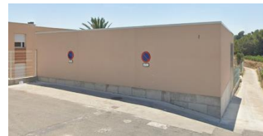
Central de producció de fred i calor
