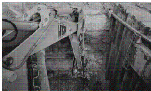
DEMOLICIÓN MECÁNICA EN ZANIA
