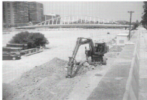
DEMOLICIÓN MECÁNICA A CIELO ABIERTO
