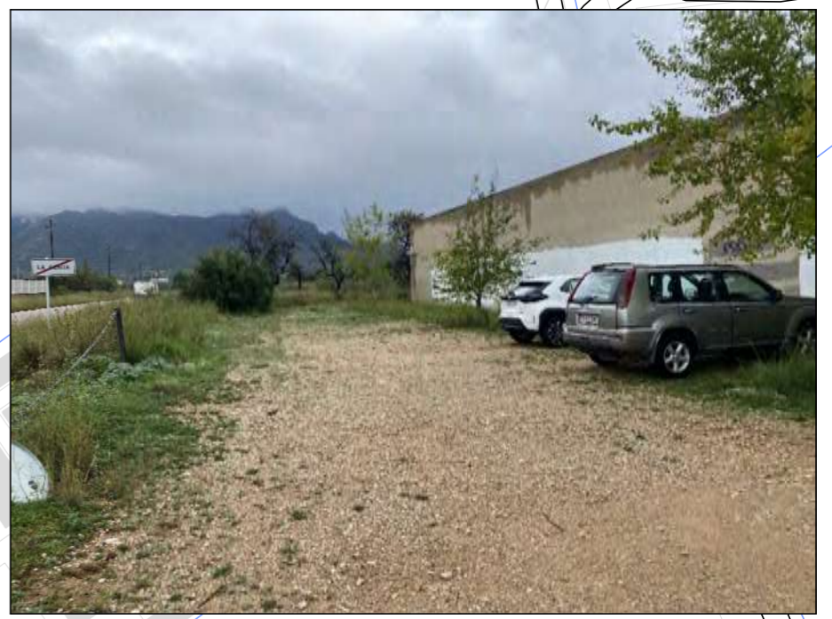
VISTA DEL MAGATZÈM DE LA BRIGADA PER ON DISCORRE LA CANONADA.
