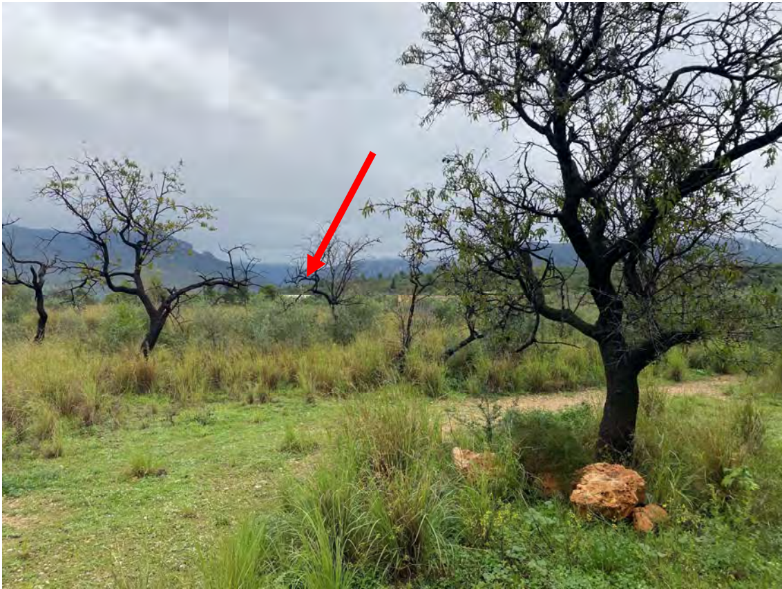
Imatge 7. Vista del dipòsit de regulació
