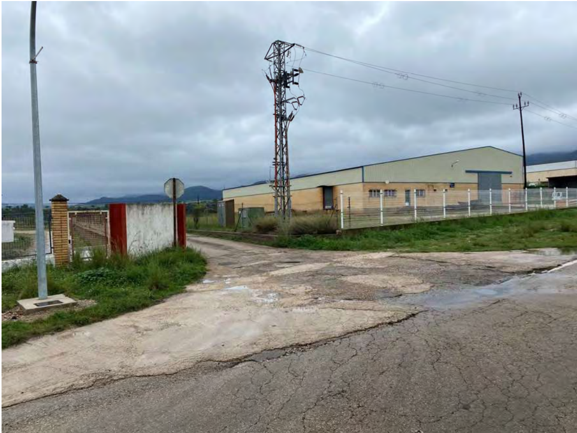
Imatge 5. Pas per la carretera de Benifassà
