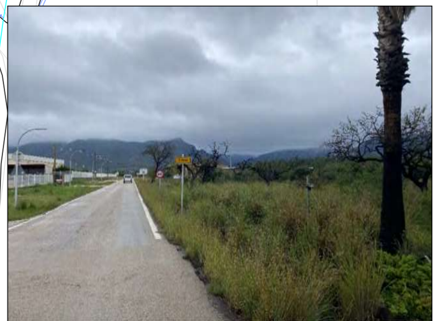
VISTA DEL RECORREGUT DE LA CANONADA
