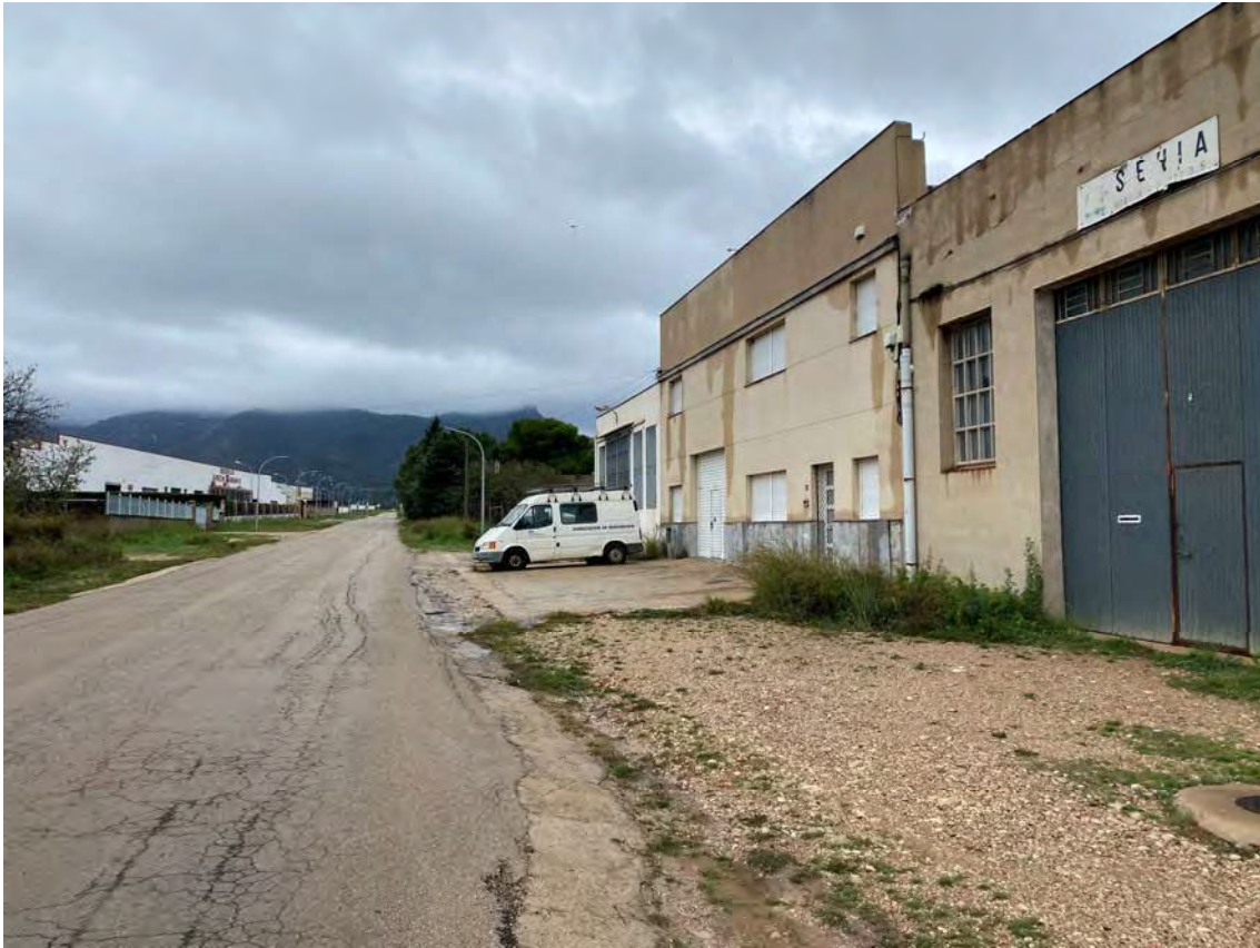
Imatge 3. Pas per la carretera de Benifassà
