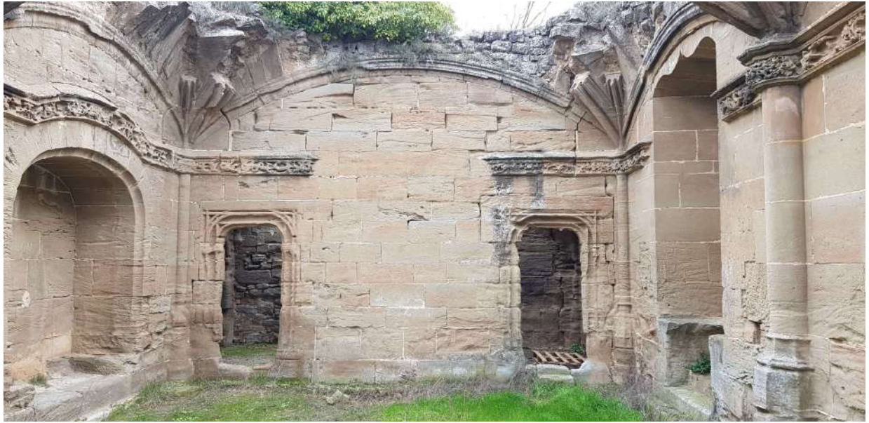
Capilla, muro Este
