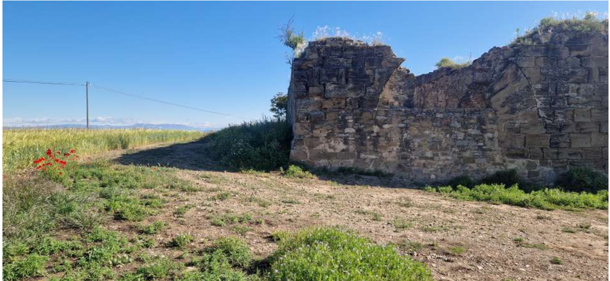
Fachada principal, parte izquierda.
