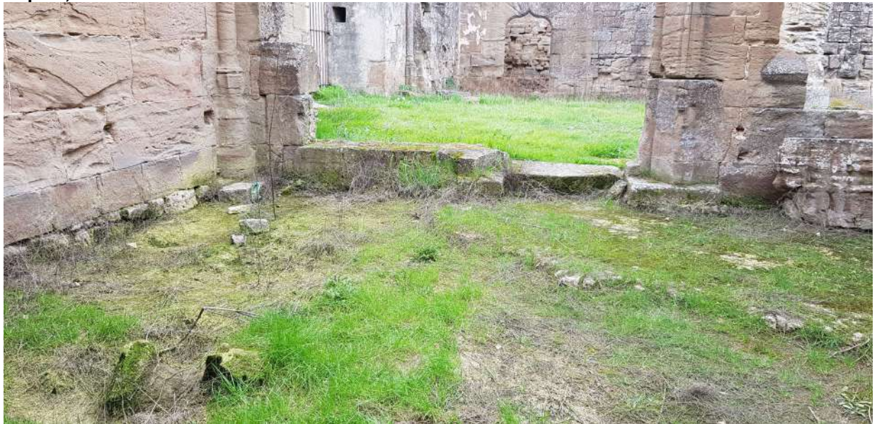
Capilla, mur Oeste y pavimento
