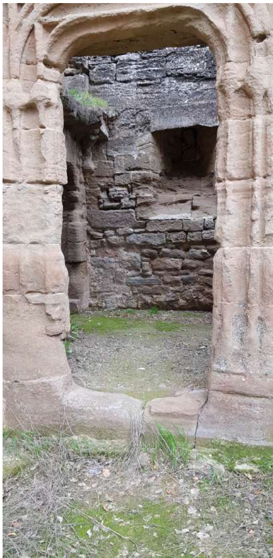
Puerta acceso zona 3
