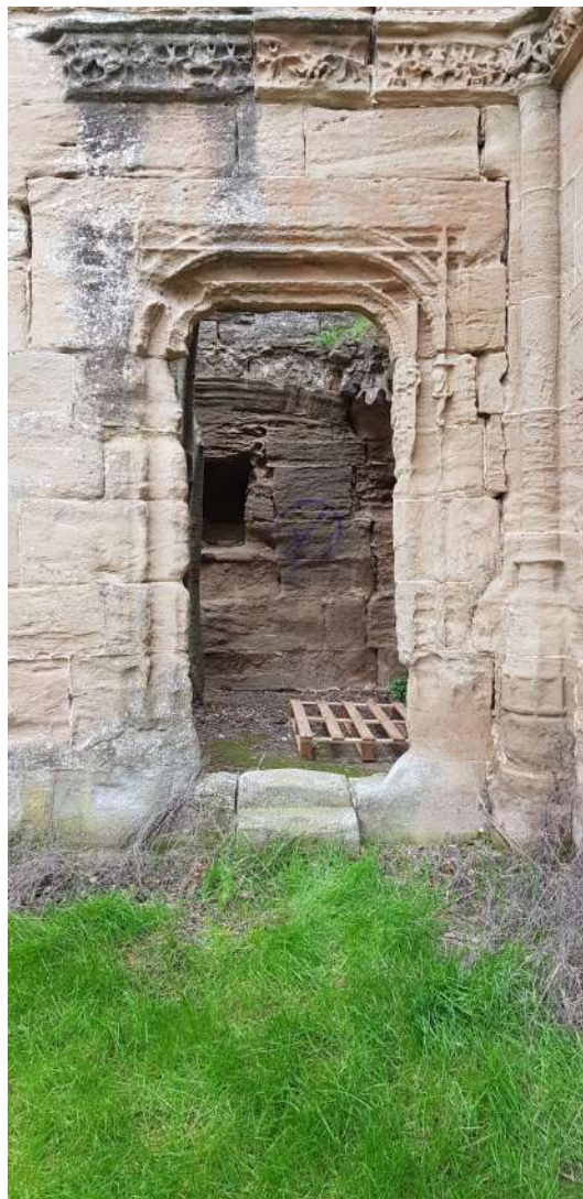
Puerta acceso zona 2
