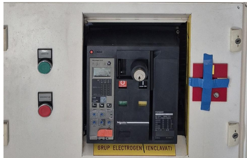
Quadre General BT (Interruptor Grup electrogen)
