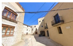
Imatge de l'estat actual de la Placeta
