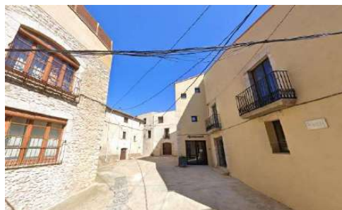
Imatge de l'estat actual de la Placeta
