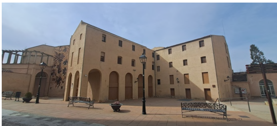
Foto 1. Vista general de l'edifici des de la plaça de Can Rius.
