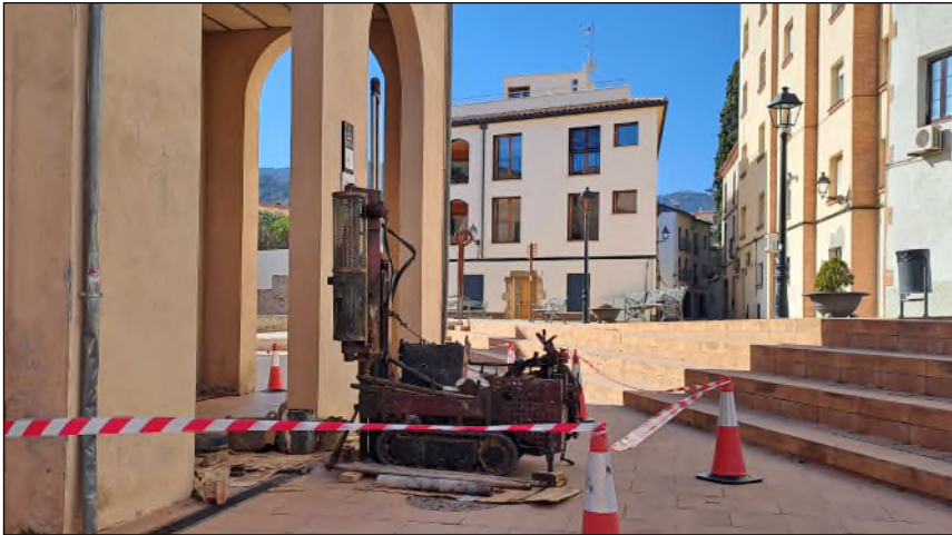
Sondeig S-2. Emplaçament
