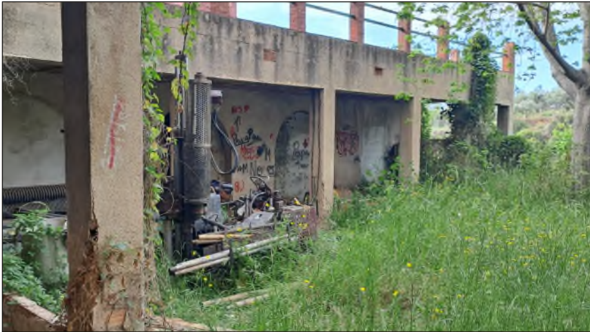
Sondeig S-1. Emplaçament
