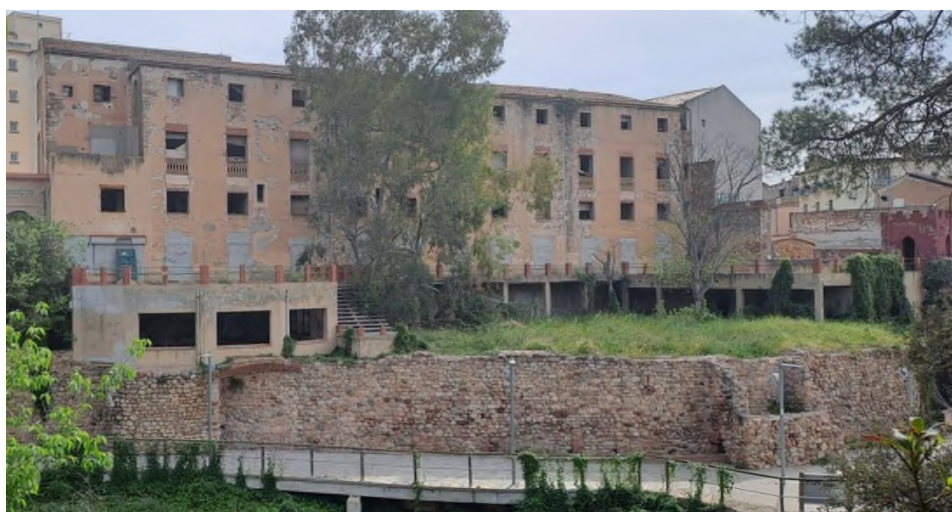
Foto 2. Vista general de la façana posterior des de l'altra banda de la riera de Caldes.
