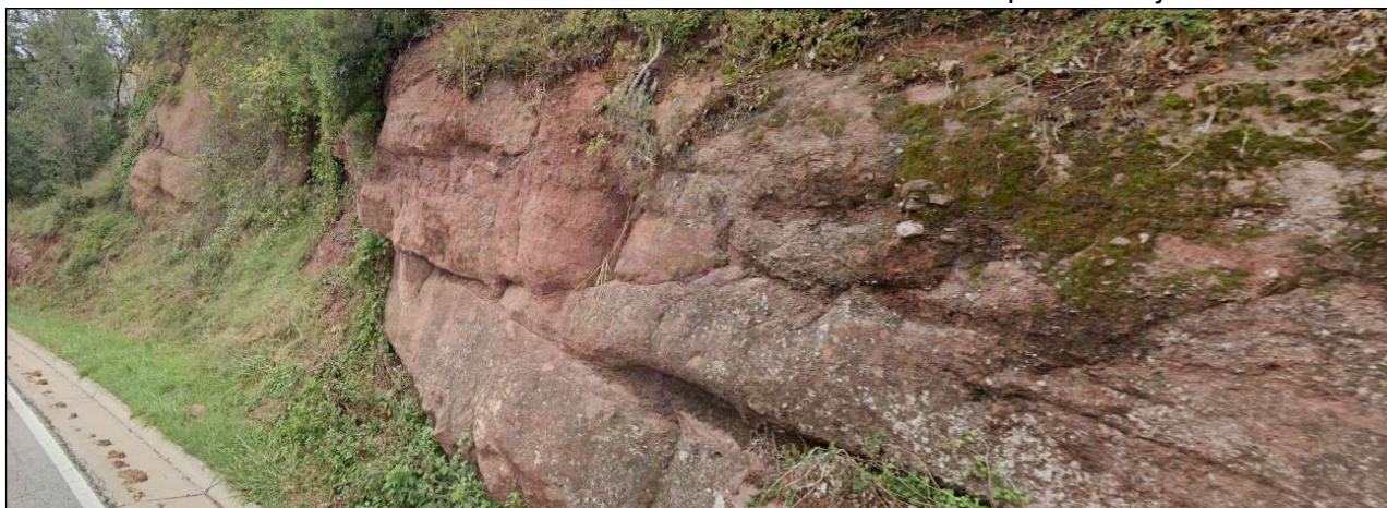
Fotografía 5: Talud sustrato rocoso calizas por debajo de cota de cimentación.
