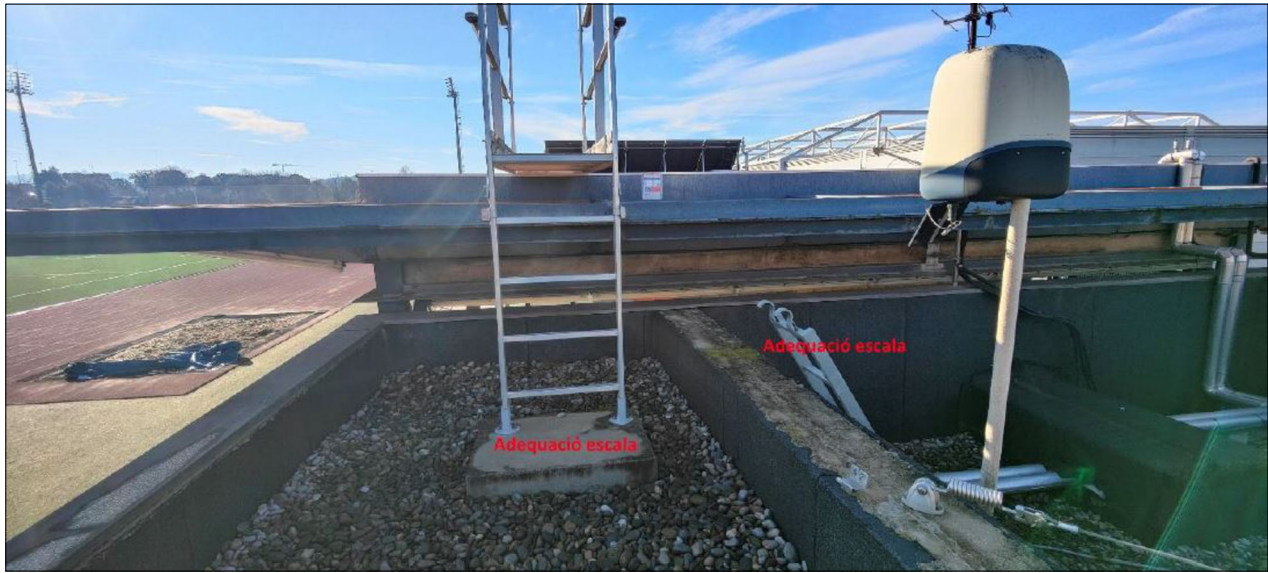
ESTAT ACTUAL COBERTA ASCENSOR
