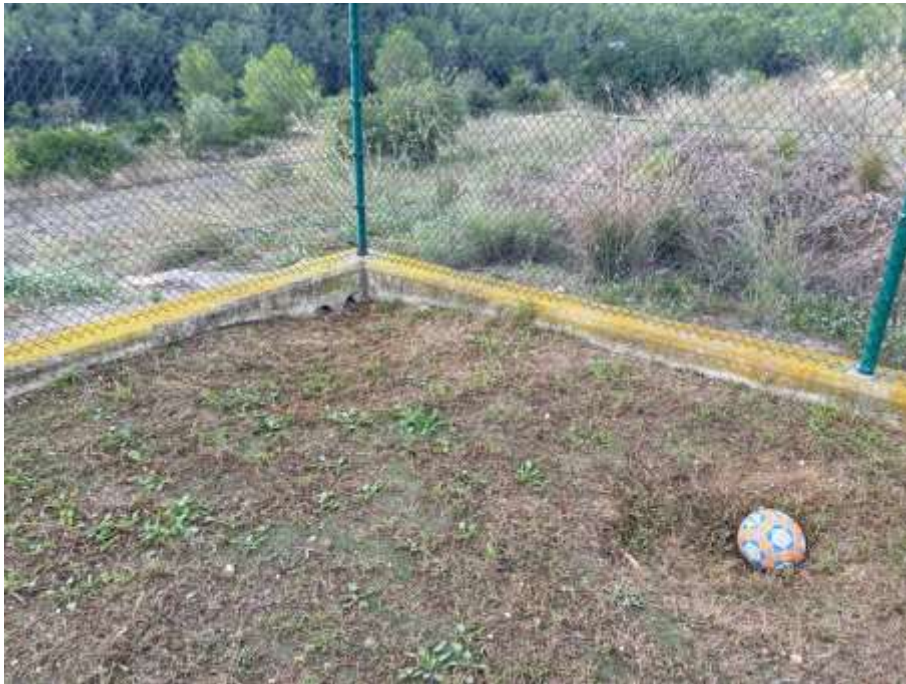
Entorn gol zona oest (s'observa sortides aigües)
