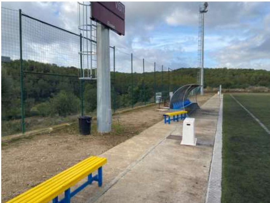
Vista zona lateral (banquetes)
