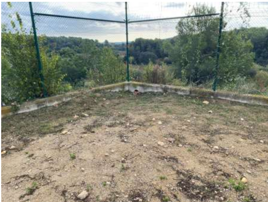
Entorn gol zona oest (s'observa sortides aigües)
