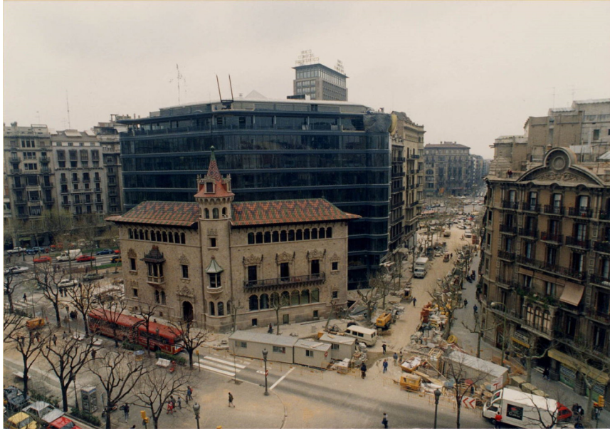
Vista panoràmica de les obres a Can Serra, 1987 AGDB. Fons: Diputació de Barcelona. Autoria desconeguda
