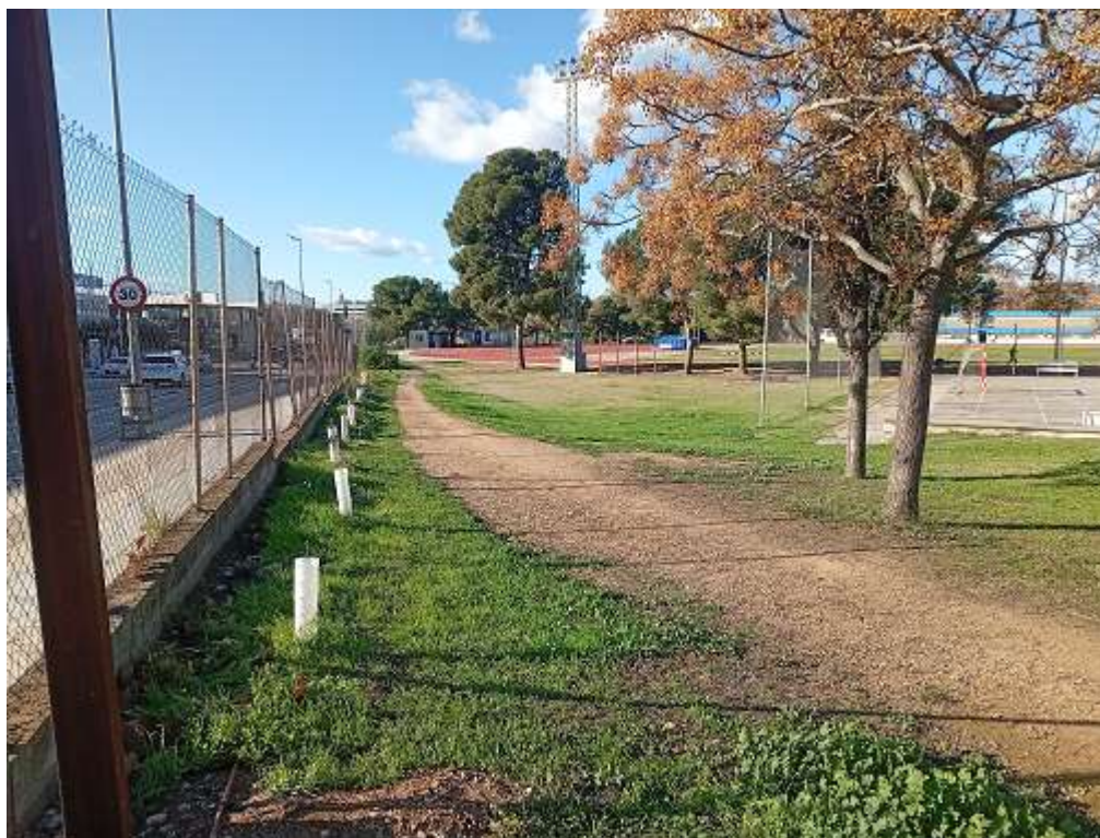
Imatge 8 . Col·locaci3n de l'armari TRAM 3, caldr3 preveure obertura reixa.
