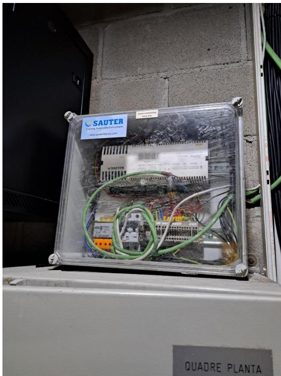
Fotografia 4: Controlador refredadora aire-aigua
