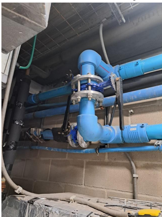
Fotografia 5: By-pass ACS planta baixa
