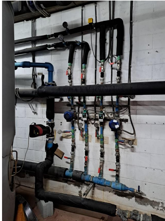
Fotografia 2: Circuits recirculació d'ACS
