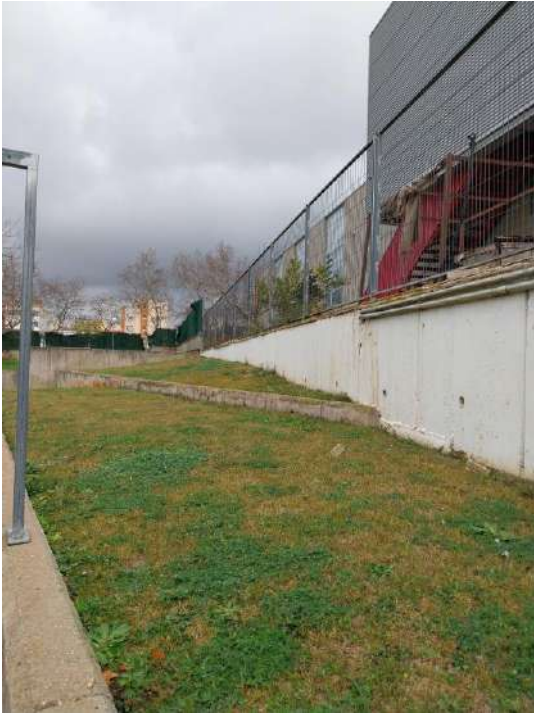
Canvi de estesa per paret a soterrada i canalització per rasa fins a nou bàcul
