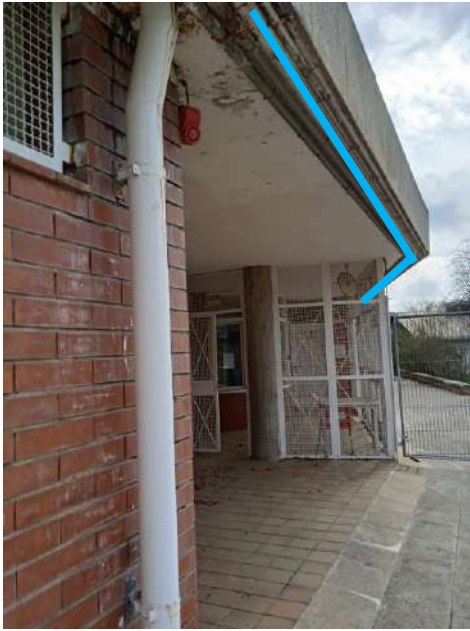
Traçat aproximat de conductor de dades per les càmeres
