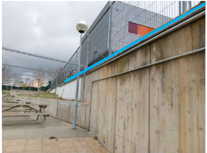
Traçat aproximat de conductor de dades per les càmeres
