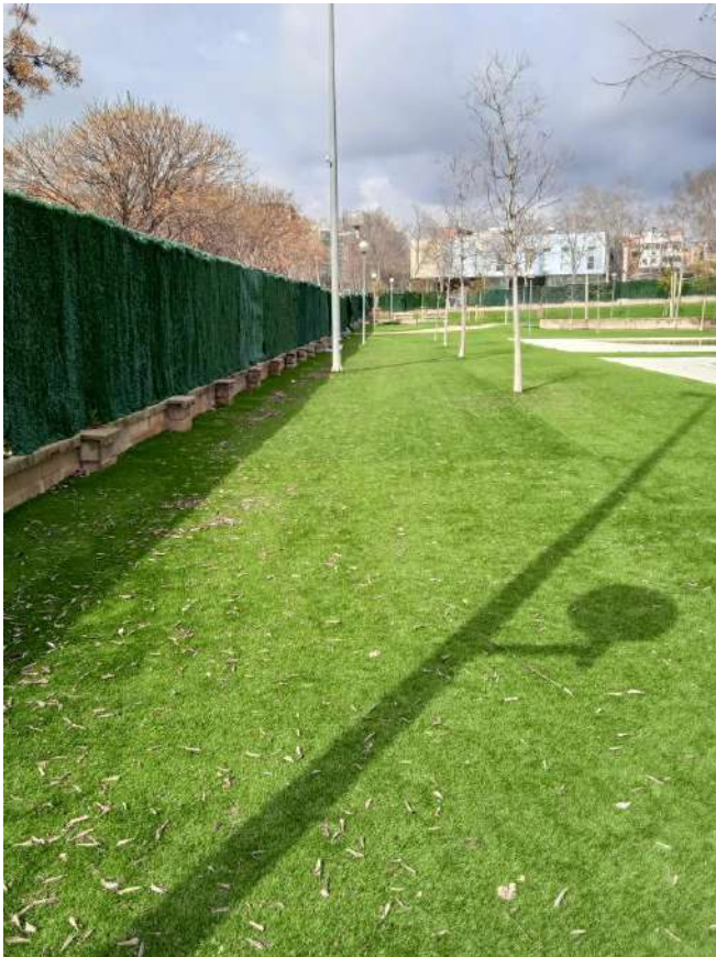
Rasa des de passa mur i pericó P3, passant per pericó P4 i P5 fins alimentació armari exterior i càmeres C6 i C7
