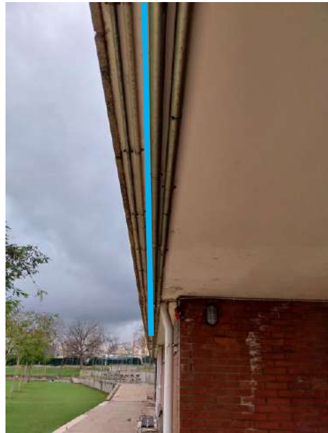
Traçat aproximat de conductor de dades per les càmeres
