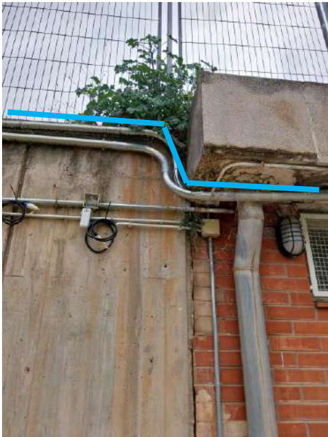
Traçat aproximat de conductor de dades per les càmeres
