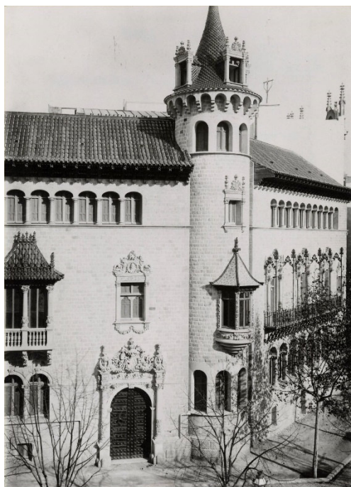
Vista parcial de la fachada de Can Serra, c. 1910-1920
