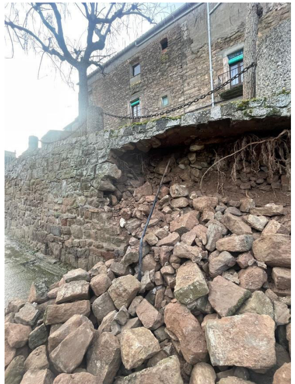
Vistes de la zona esfondrada del mur des del carrer Empedrat. Font: pròpia
