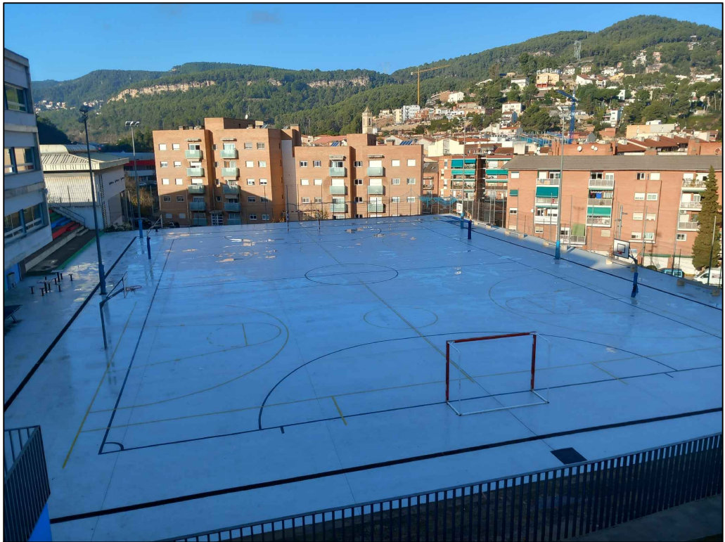
Imatge actual de la pista esportiva
