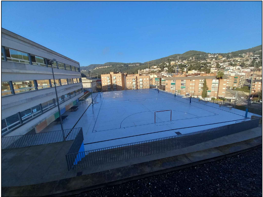
Imatge actual de la pista esportiva
