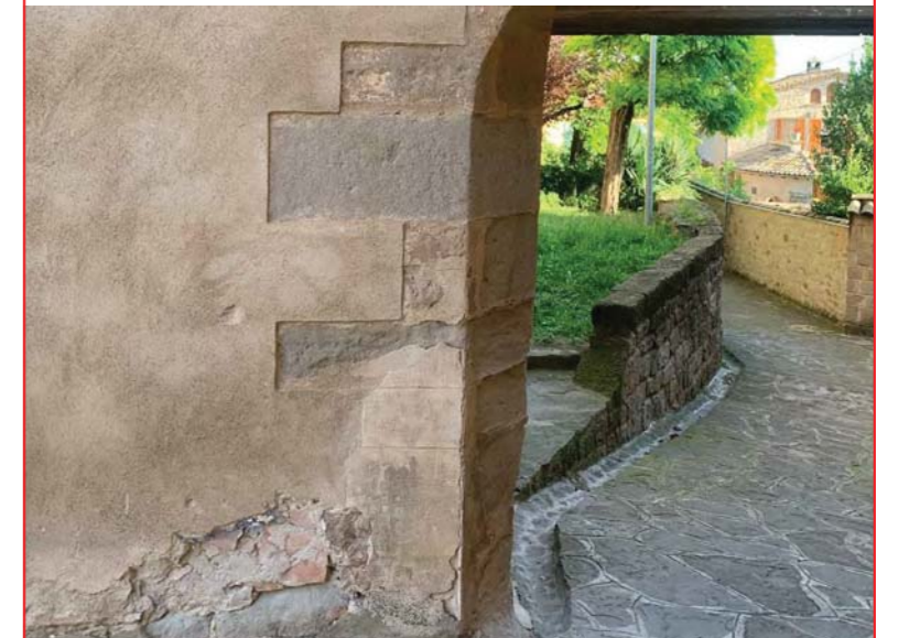
-Retir d'estuc en mal estat i col·locació de nou estuc igual a l'existent en cantonada de la façana sud amb oest
