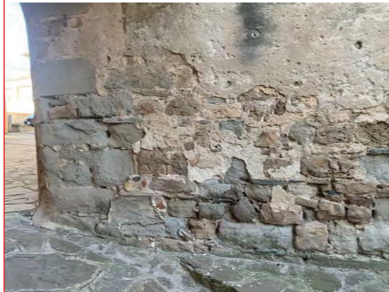
-Retir d'estuc en mal estat i col·locació de nou estuc igual a l'existent en cantonada de la façana sud amb oest
