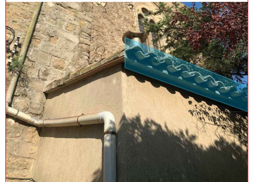
-Retir d'instal·lació pluvial existent per canonades de coure noves -Desembocant en la connexió actual -Instal·lació de canal nou de coure en les cobertes assenyalades
