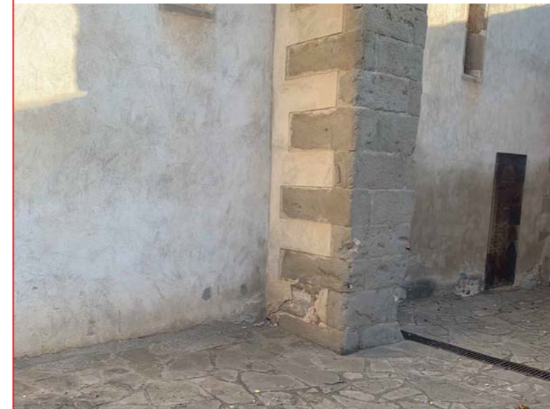
-Reparació d'estuc en laterals dels contraforts
