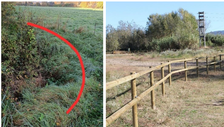
Figures 8 i 9. Imatge del tram amb risc de caiguda on anirà col·locada la tanca (esquerra) i exemple de l'estil de tanca texana desitjat
