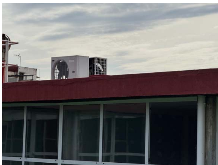
Desmuntatge d'unitats exteriors d'expansió directa ubicades a la coberta de l'edifici.
