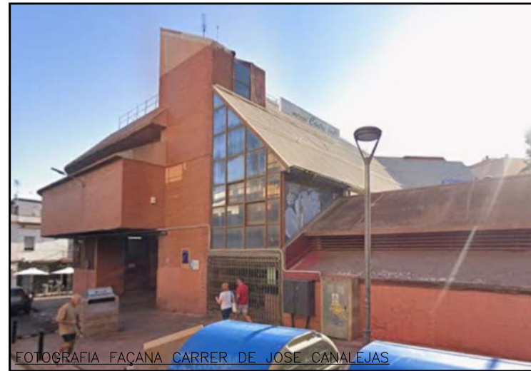
FOTOGRAFIA FAÇANA CARRER DE JOSE CANALEJAS
