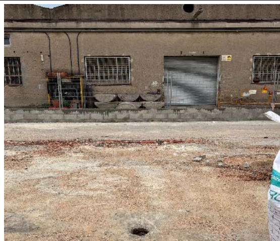
Dipòsit enterrat (foto client)
