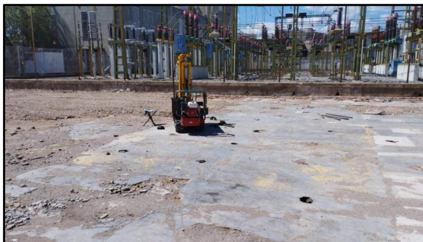
Diferents vistes del solar d'estudi amb la maquinaria de sondeigs emplaçada. D'esquerra a dreta i de dalt a baix, situació de l'assaig P-1, el sondeig S-6, l'assaig de penetració P-2 associat, el sondeig S-7, i l'assaig P-4.
