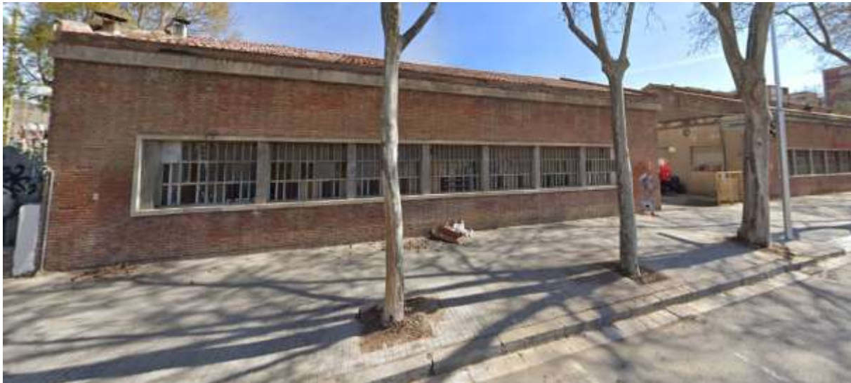
Figura 3. Fotografía de la fachada sobre Rambla de Prim extraída de Google Maps en 2024. Esta edificación fue derribada por el Ayuntamiento.
