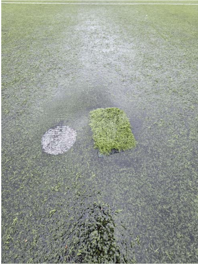
Foto 9. Reparació puntual i acumulació d'aigua.
