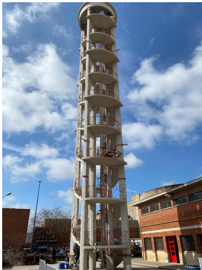
Torre de pràctiques
