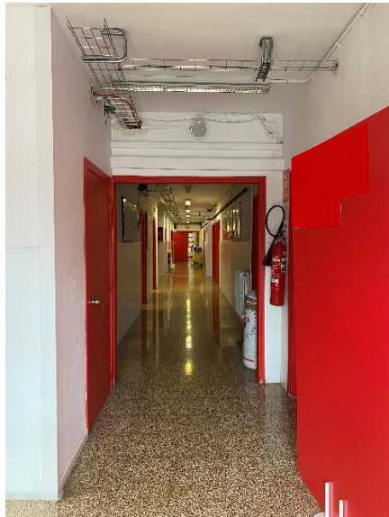
Espai de circulació des de la porta d'accés
