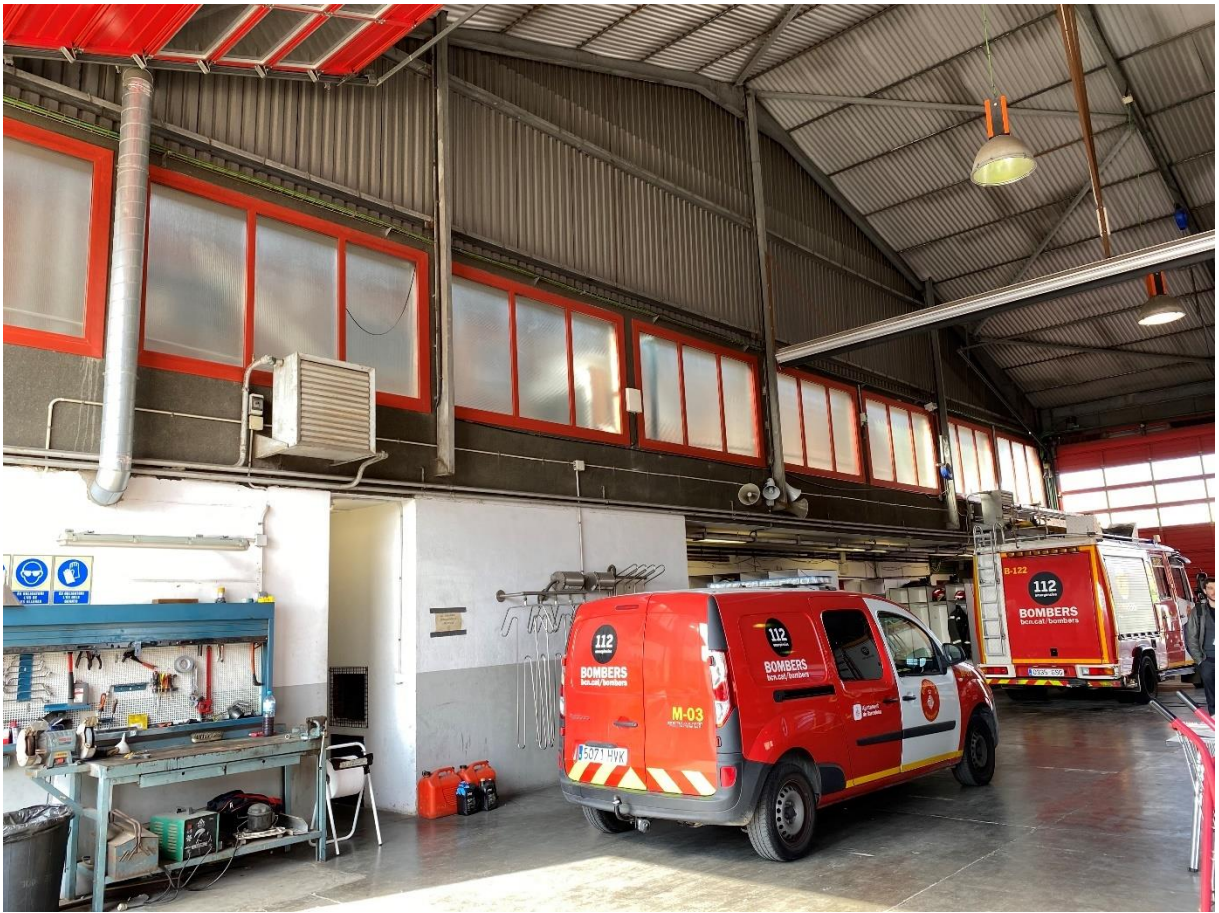
Sala d'útils amb banc de treball
