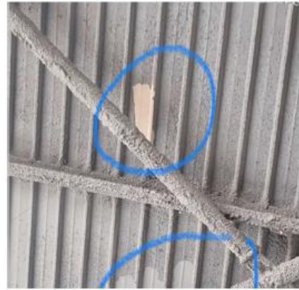
Coberta Zona Accés Espai Bital
