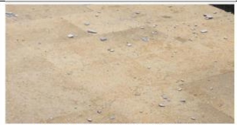
Restes dels despreniments a terra
