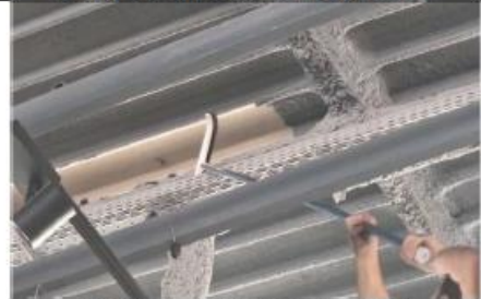
Neteja estructura Espai Bital
