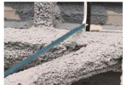
Neteja estructura Espai Bital
