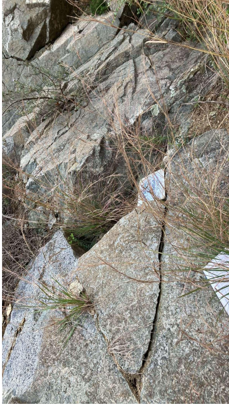
Fotografia 6. Punt realització estació geomecànica(EGM1) i mostreig de la mostra EGM1-MR1 (27/02/2025)
