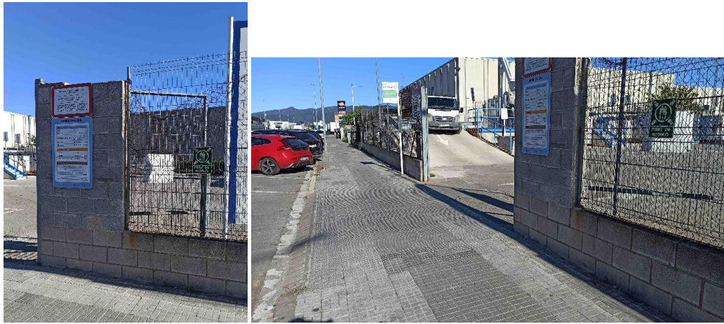
Fotografies 6-7. Vista de l'entrada principal des de l'exterior. Es pot apreciar la tanca metàl·lica, el mur de bloc, els cartells indicadors, entre d'altres.
