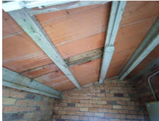
Fotografia 6 Sostre de la caseta, amb l'obertura tancada amb taulons de fusta
