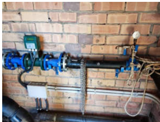
Fotografia 3 Detall del comptador on es situarà la nova vàlvula
