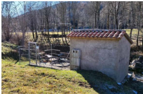
Fotografia 7 Exterior de la caseta on s'aprecia l'actual tanca perimetral
